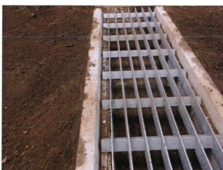
Strippen hart op hart 150 mm
