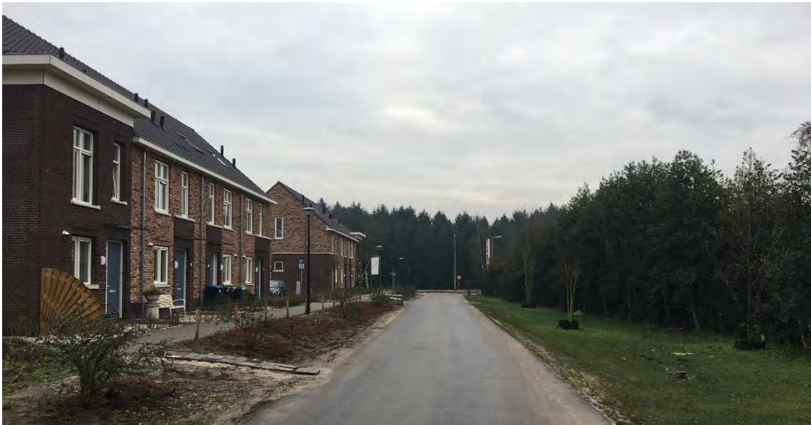
Foto Kersengarde tijdens aanleg
