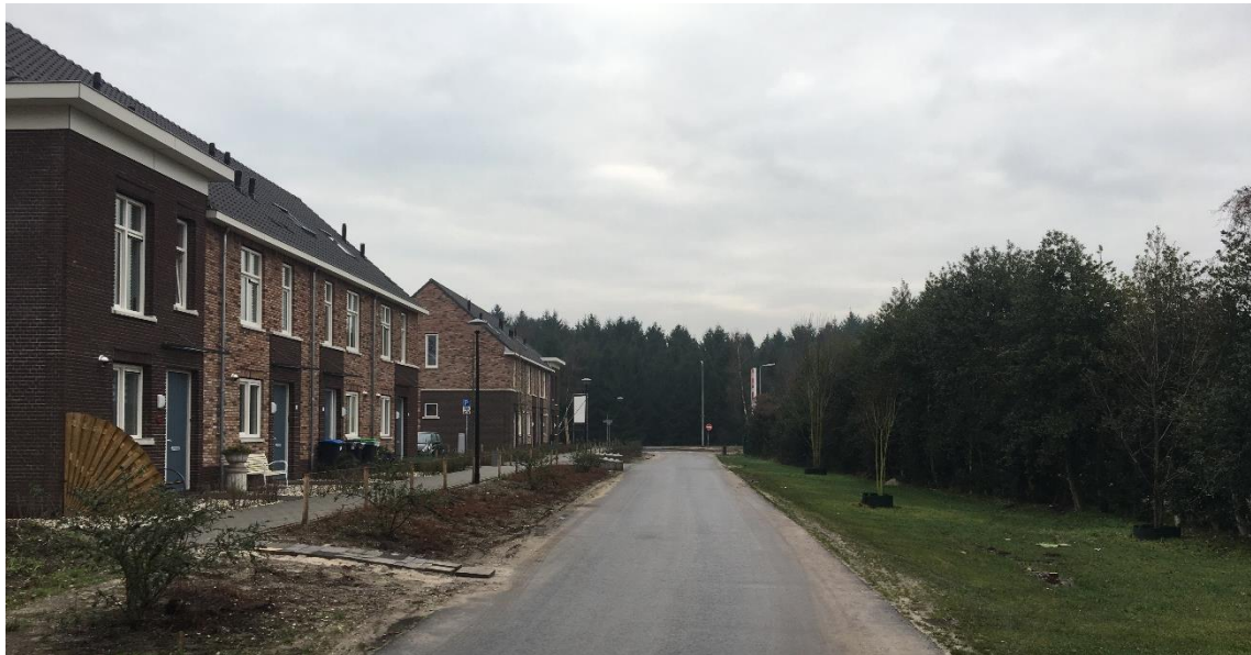
Foto Kersengarde tijdens aanleg
