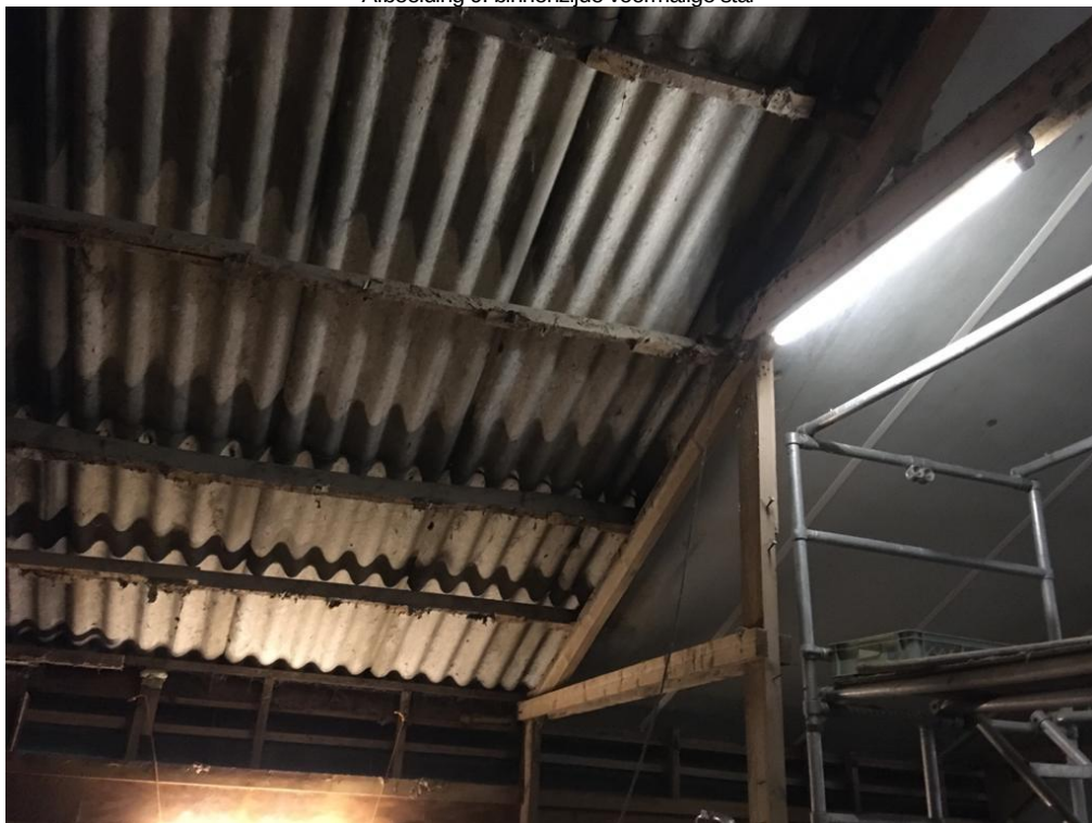
• Afbeelding 9: binnenzijde voormalige stal
