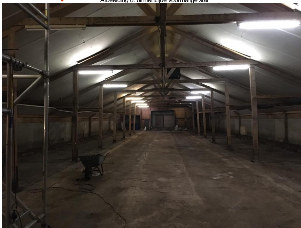
• Afbeelding 8: binnenzijde voormalige stal
