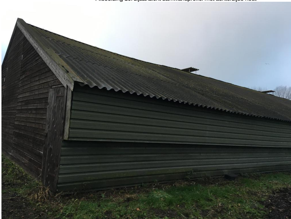
• Afbeelding 10: zijaanzicht damwandprofiel met achterzijde hout
