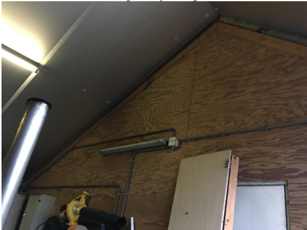
• Afbeelding 6: binnenzijde voormalige stal
