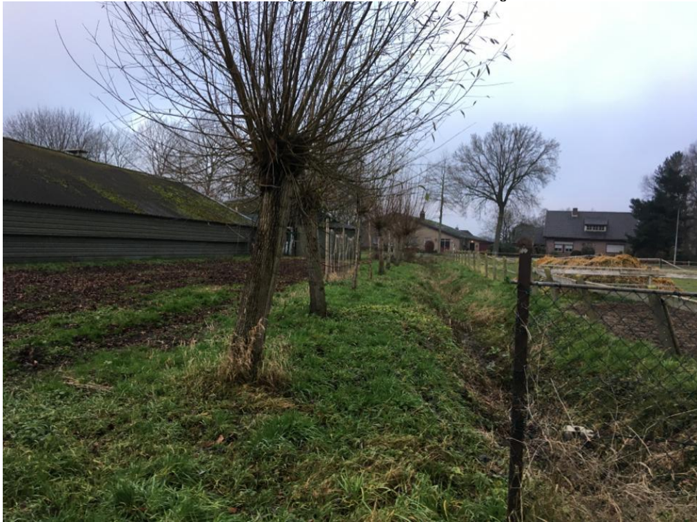
• Afbeelding 5: zij aanzicht te slopen bebouwing
