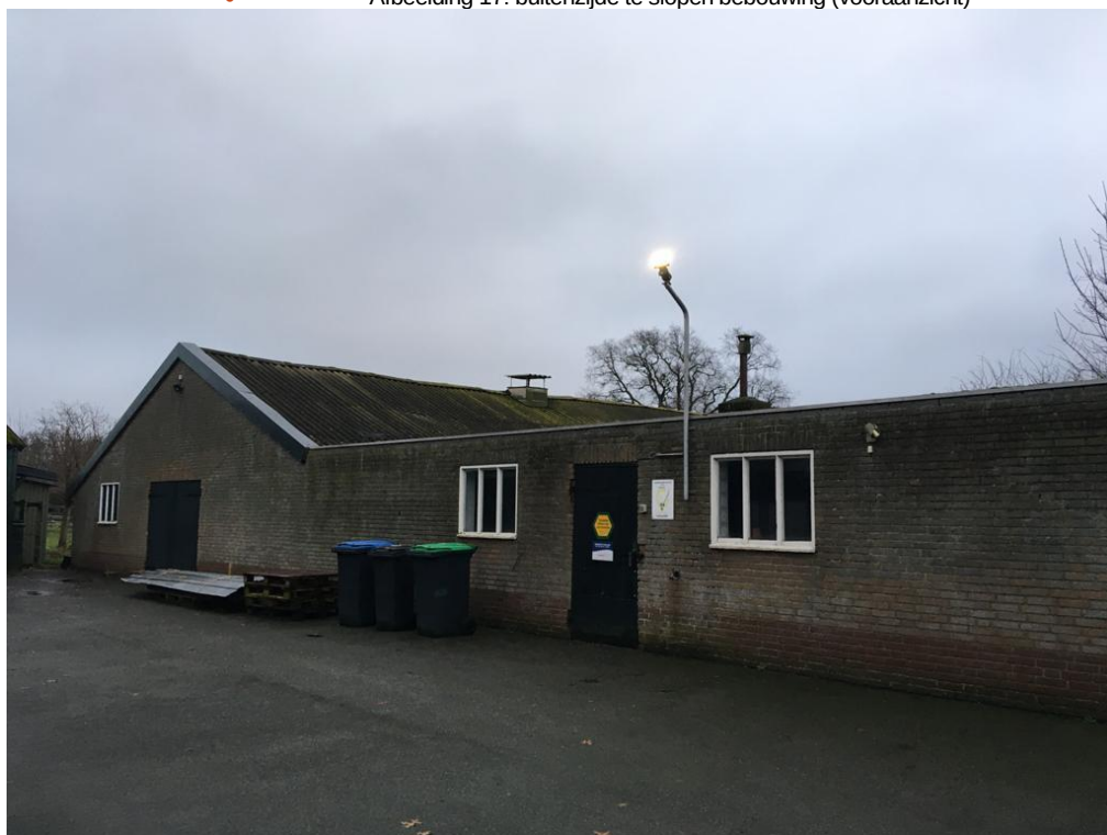
• Afbeelding 17: buitenzijde te slopen bebouwing (vooraanzicht)
