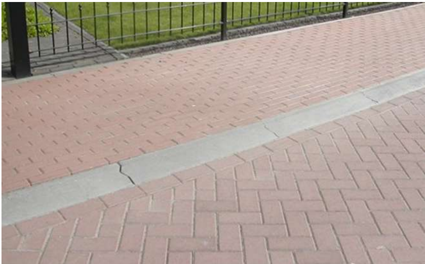
Rode betonklinkers en fietsopsluitbanden
