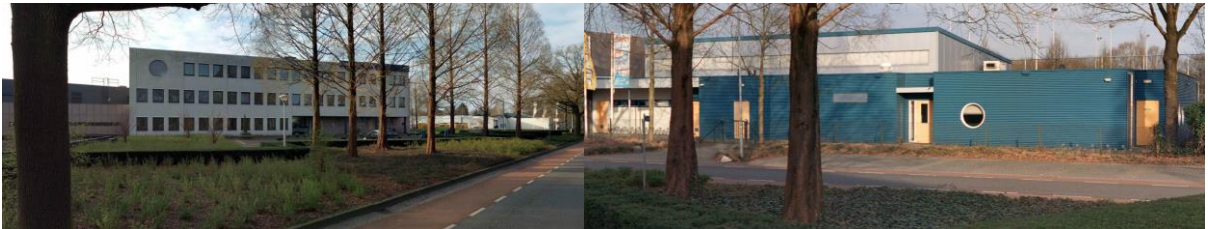
Zicht op het ten zuiden gelegen kantoorpand
