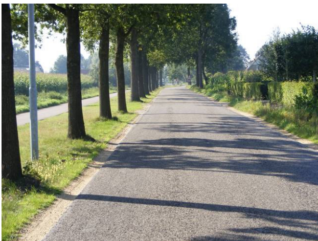
Foto 2: Ruitersweg (richting Eikenheuvelweg)
