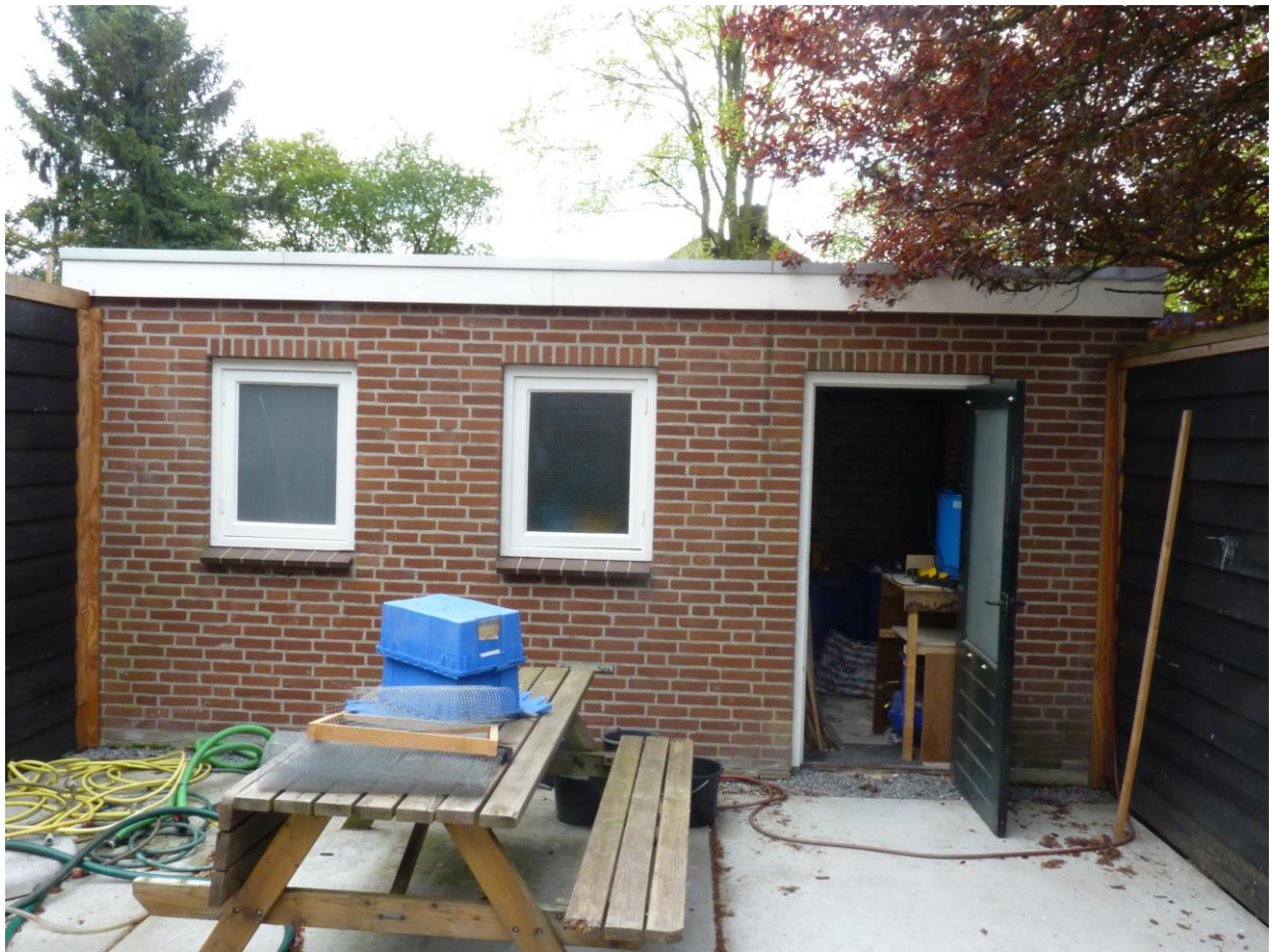
Bijgebouw 2 heeft een spouwmuur
