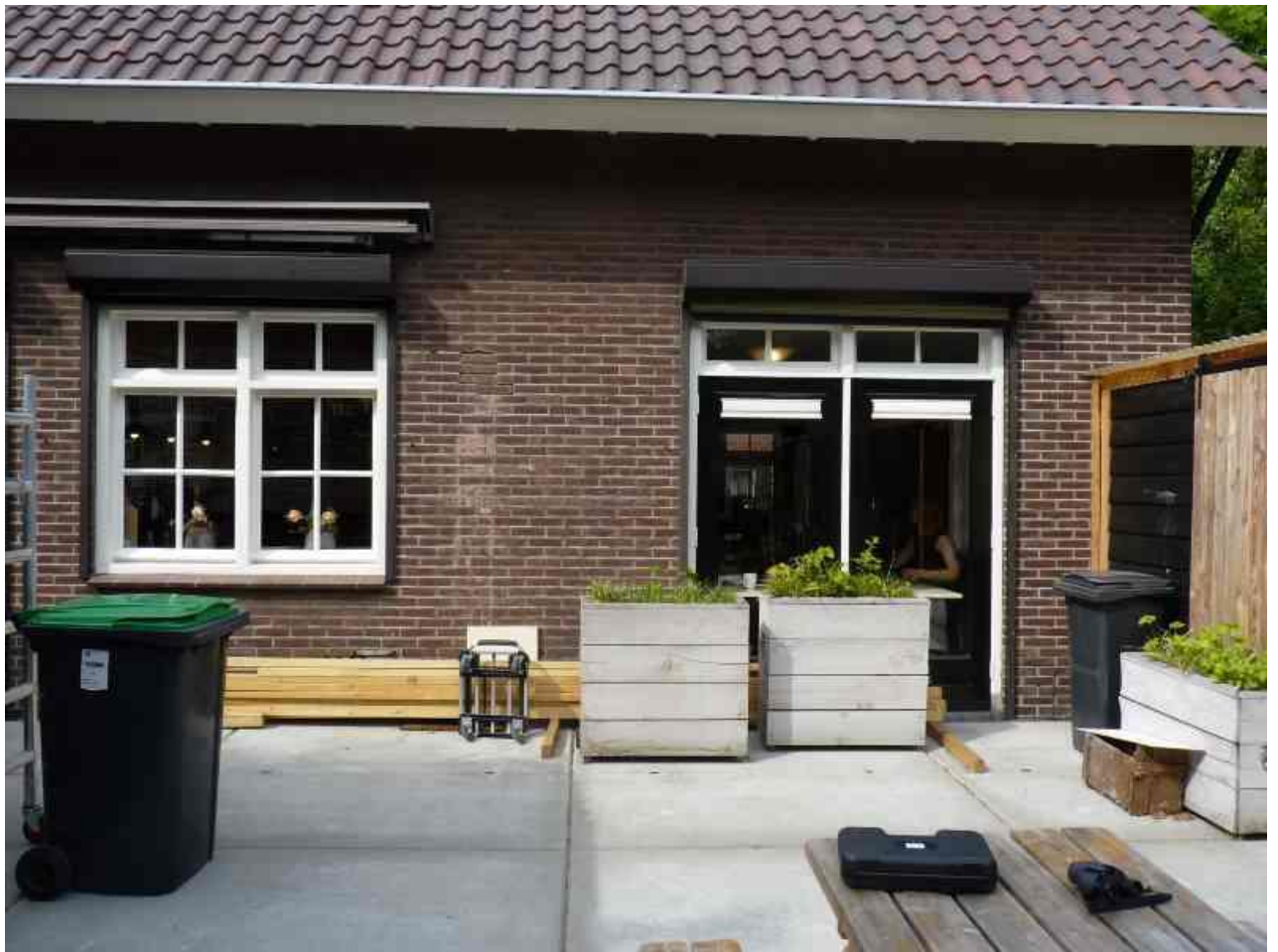
Achterzijde van het hoofdgebouw
