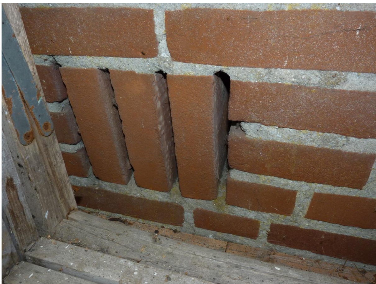
Ventilatioerooster vlak boven de grond
