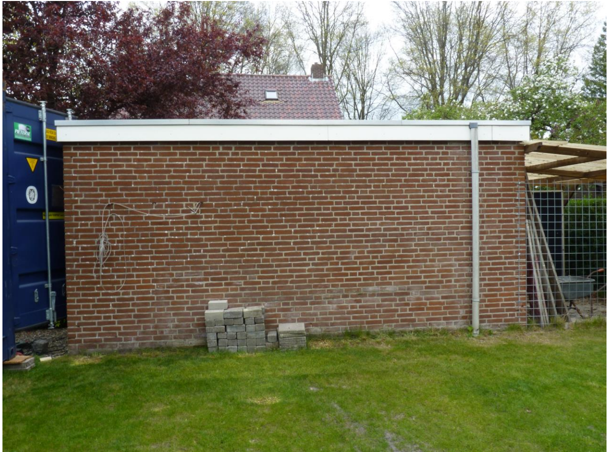
Blinde muur van bijgebouw 2 zonder ventilatievoegen
