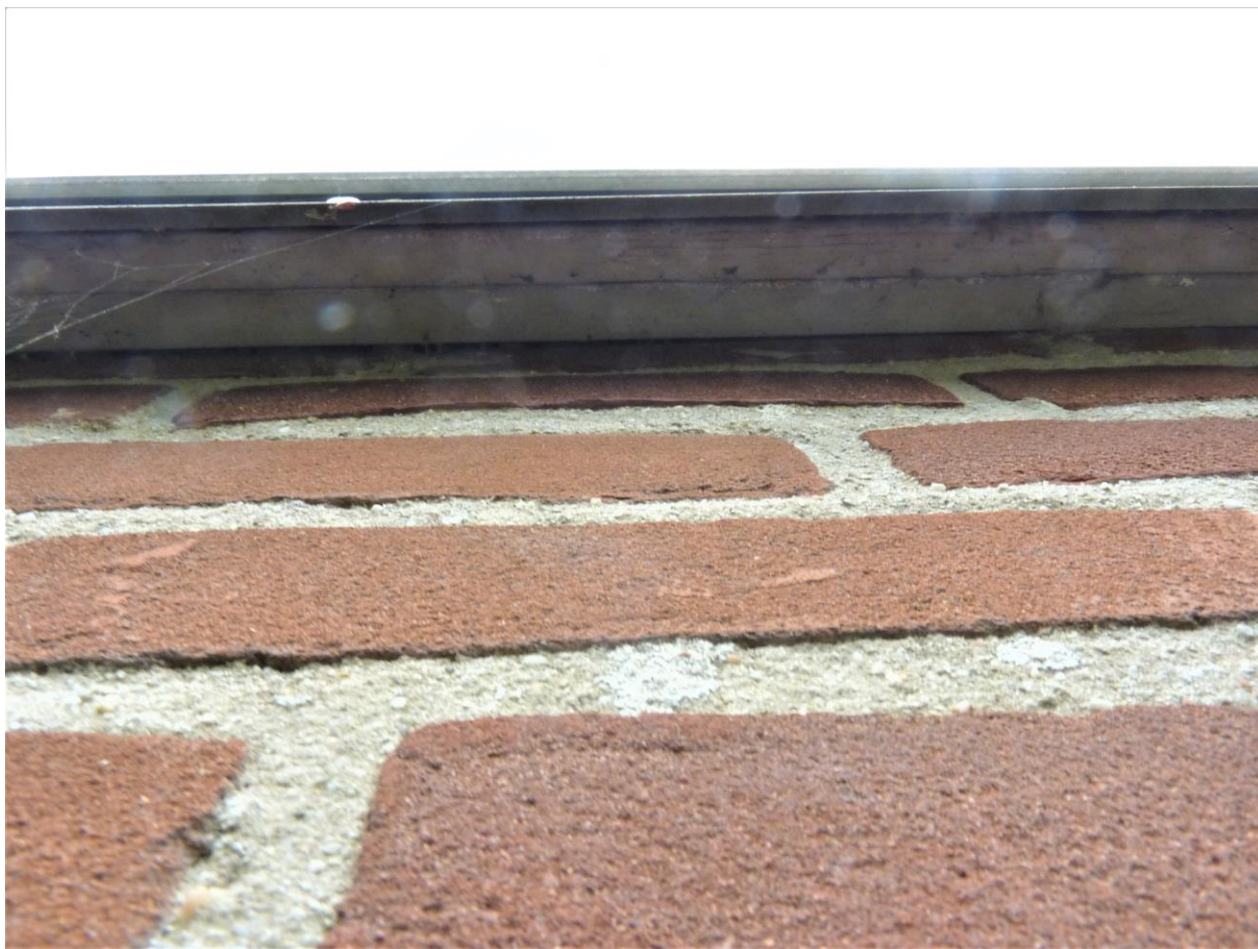
Dakrand zonder openingen
