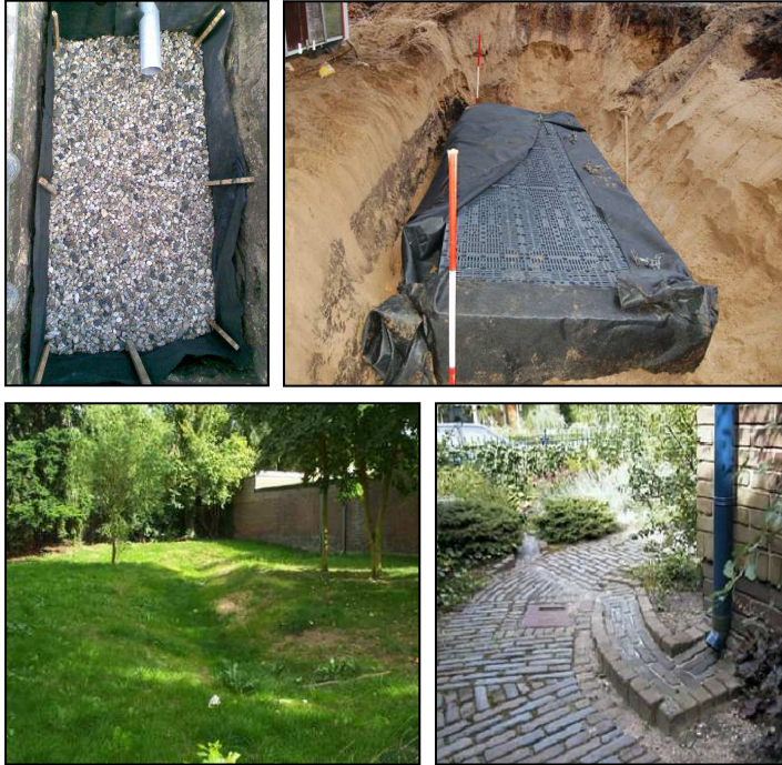
Figuur 26: Voorbeelden infiltratievoorzieningen
