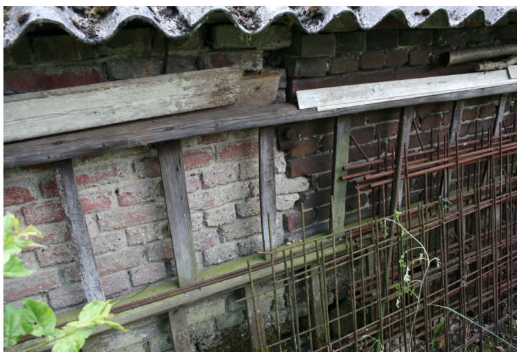
Overgang kalkzandsteen - baksteen
