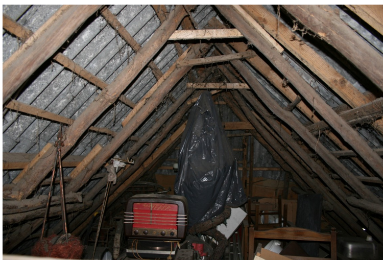
Kapconstructie ter hoogte van het achterhuis
