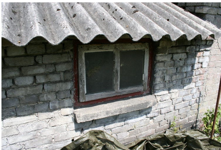
Klepvenster ter hoogte van de slaapkamer
