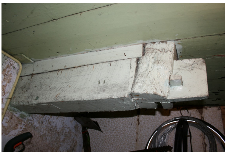
Afgezaagde stijl met telmerk II in de slaapkamer
