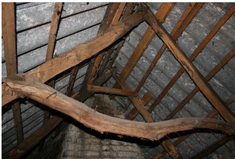
Gespijkerde hanenbalk ter hoogte van het voorhuis
