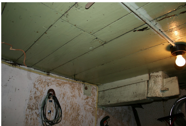
Houten plafond slaapkamer
