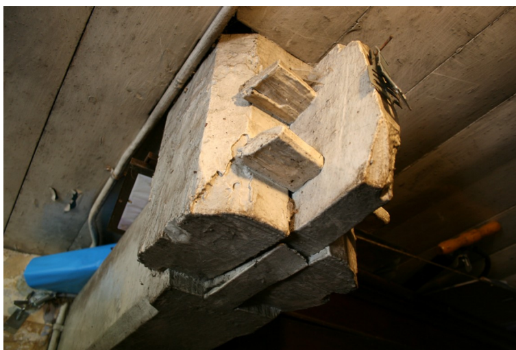
Afgezaagde stijl met telmerk I in de voormalige goede kamer
