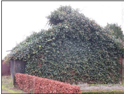
Foto 3. Te slopen stal met klimop
