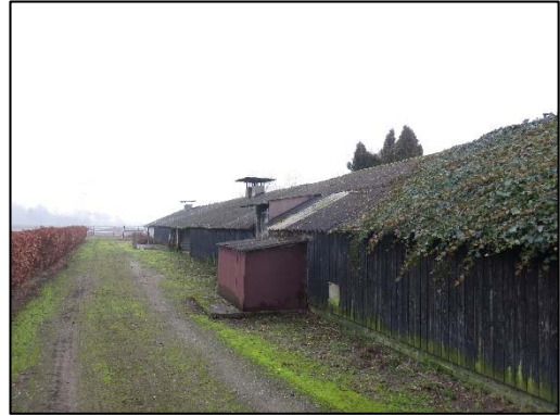
Foto 4. Noordzijde van de te slopen stal
