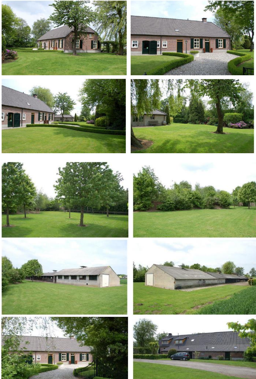
Figuur 6 Huidige beplanting planlocatie en te slopen voormalige bedrijfsbebouwing
