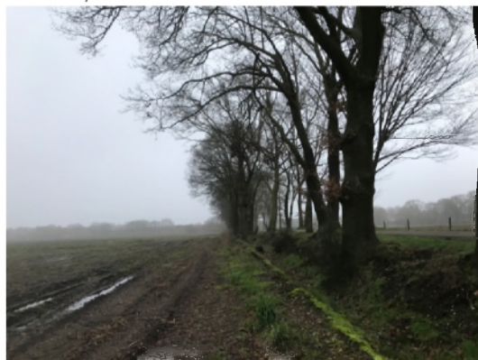
4. Osseweg met droge sloot en boombeplanting
