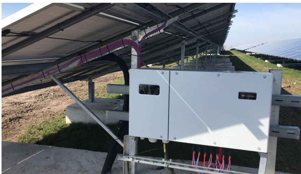
Figuur 7: Impressie stringomvormer
