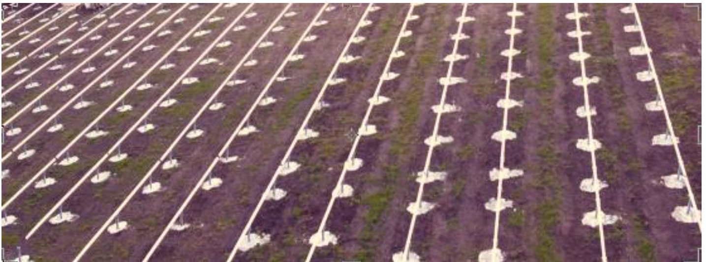
Figuur 7: impressie toepassing betonvoeten op vlakke delen (stortplaats Armhoede, Lochem)
