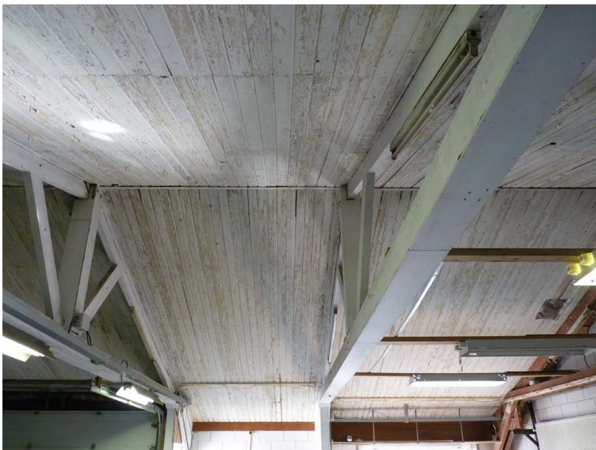
Dakconstructie van binnen gezien.
