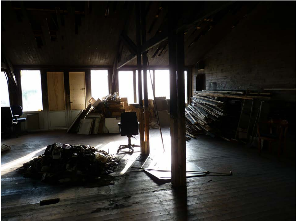
Zwartgeblakerd deel van het gebouw
