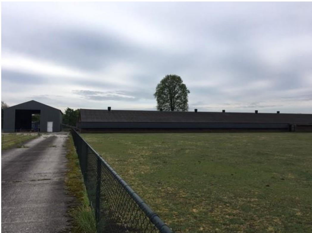
• Afbeelding 11; Zijaanzicht te slopen pluimveestal en vooraanzicht mestoverslag en werktuigenberging
