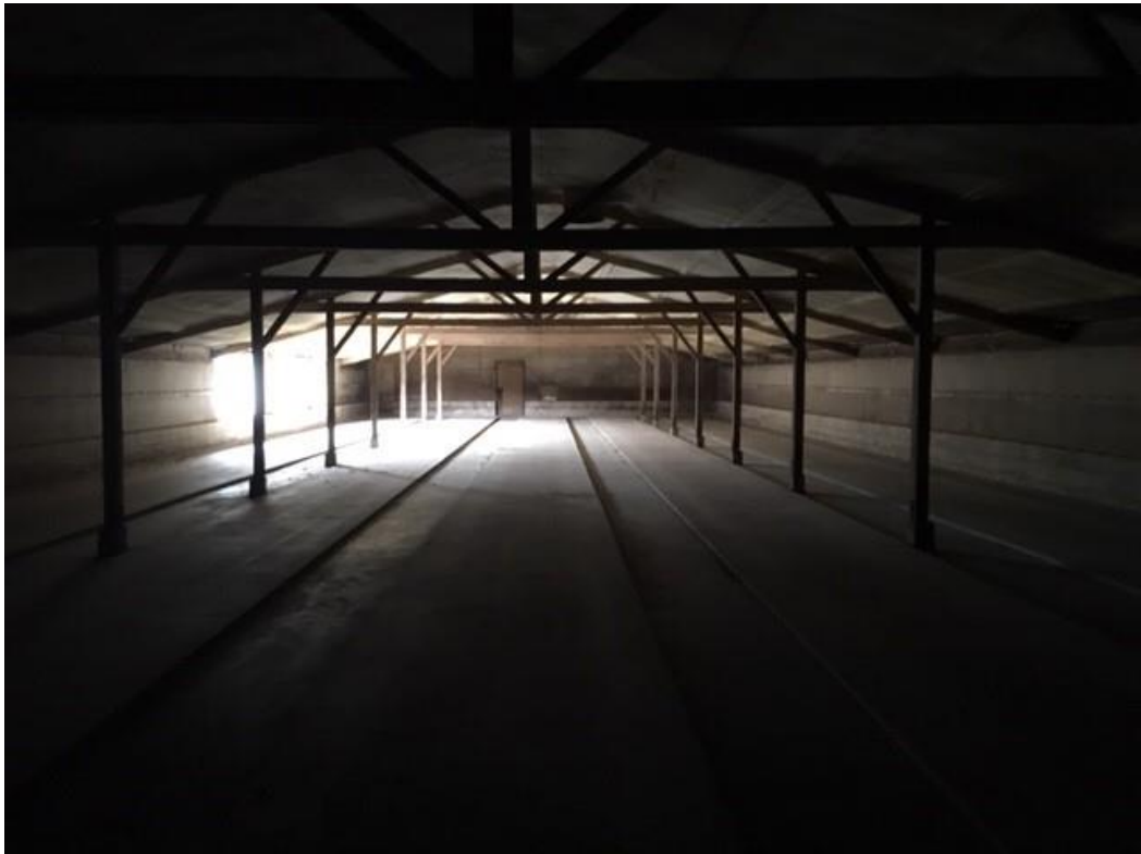
• Afbeelding 12; Binnenzijde te slopen pluimveestal
