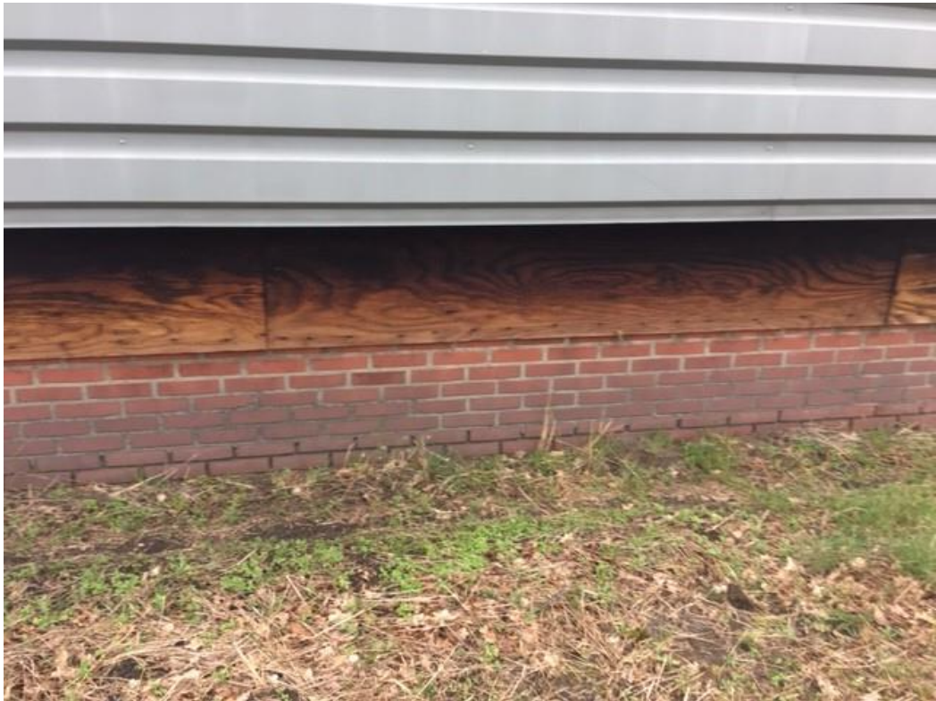
• Afbeelding 14; Detail zijwand pluimveestal
