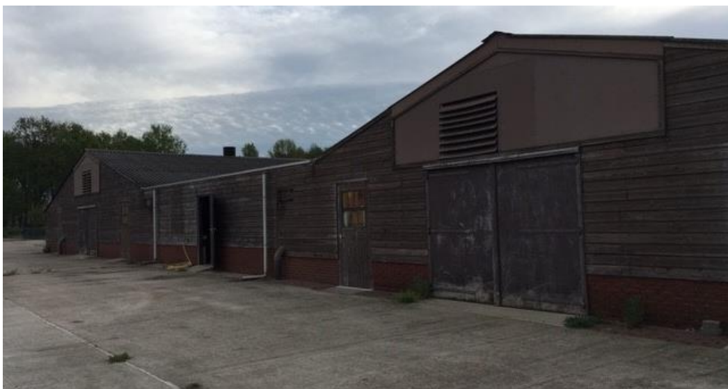
• Afbeelding 7; Voorzijde de te slopen stalgebouwen
