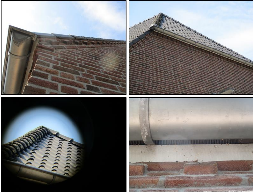
Figuur 3 Door het strak aansluiten van de kantpannen, het ontbreken van openingen onder de dakgoot en de aanwezigheid van vogelwerend middel onder de nokpannen en onder de onderste rij dakpannen, kan de aanwezigheid van vleermuizen uitgesloten worden.
