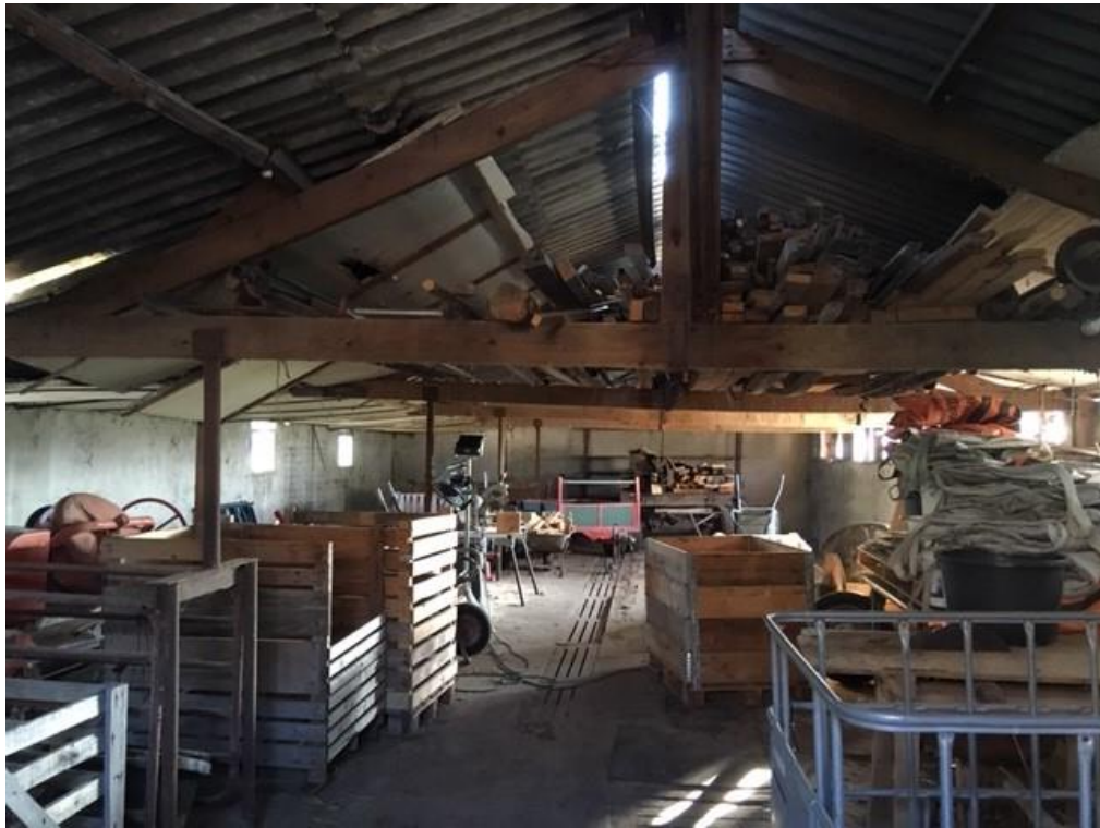
• Afbeelding 8: binnenzijde en opslag diversen te slopen gebouw
