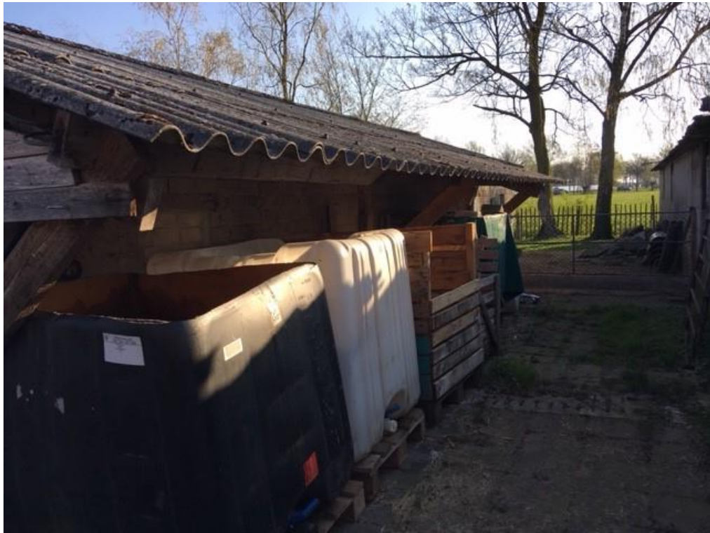
• Afbeelding 6: buitenzijde te slopen gebouwen
