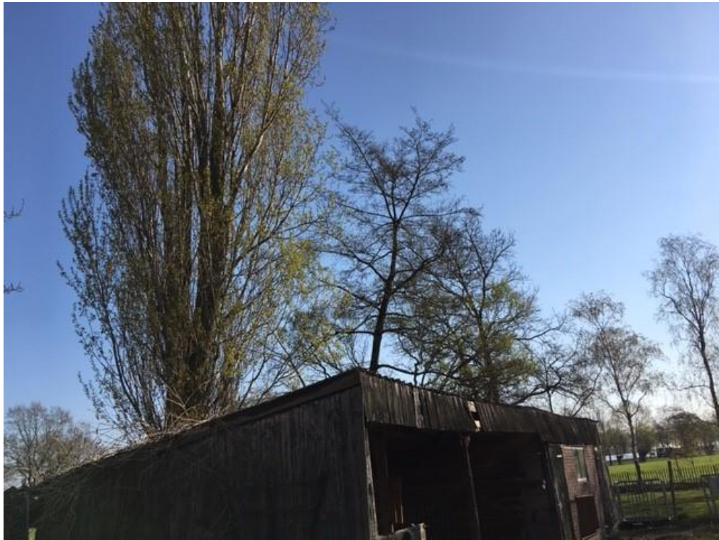
• Afbeelding 14: achterzijde plangebied met te slopen gebouw
