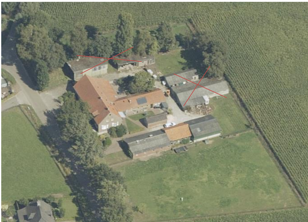
• Afbeelding 1: luchtfoto plangebied met te slopen gebouwen (bron: streetsmart.cyclomedia.com/streetsmart )
