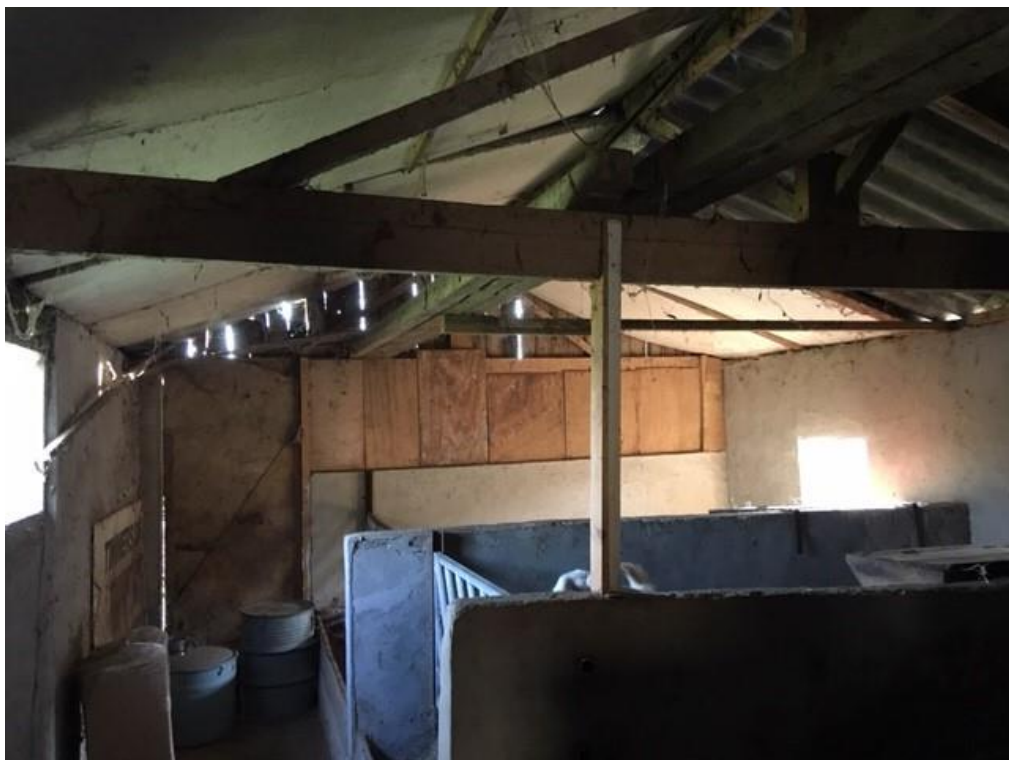
• Afbeelding 9: binnenzijde en opslag diversen te slopen gebouw
