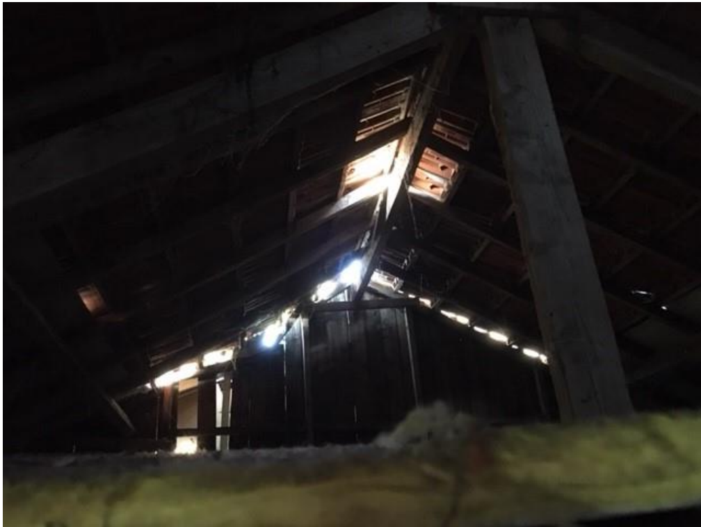
• Afbeelding 12: detail dakconstructie te slopen gebouw
