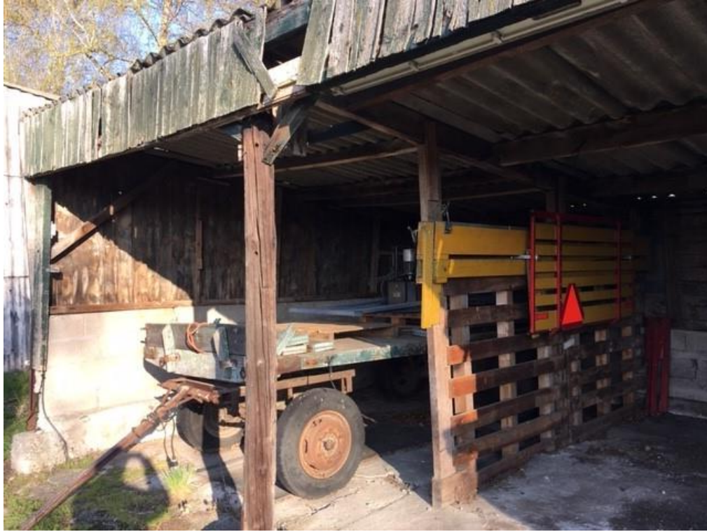
• Afbeelding 5: buitenzijde te slopen gebouwen
