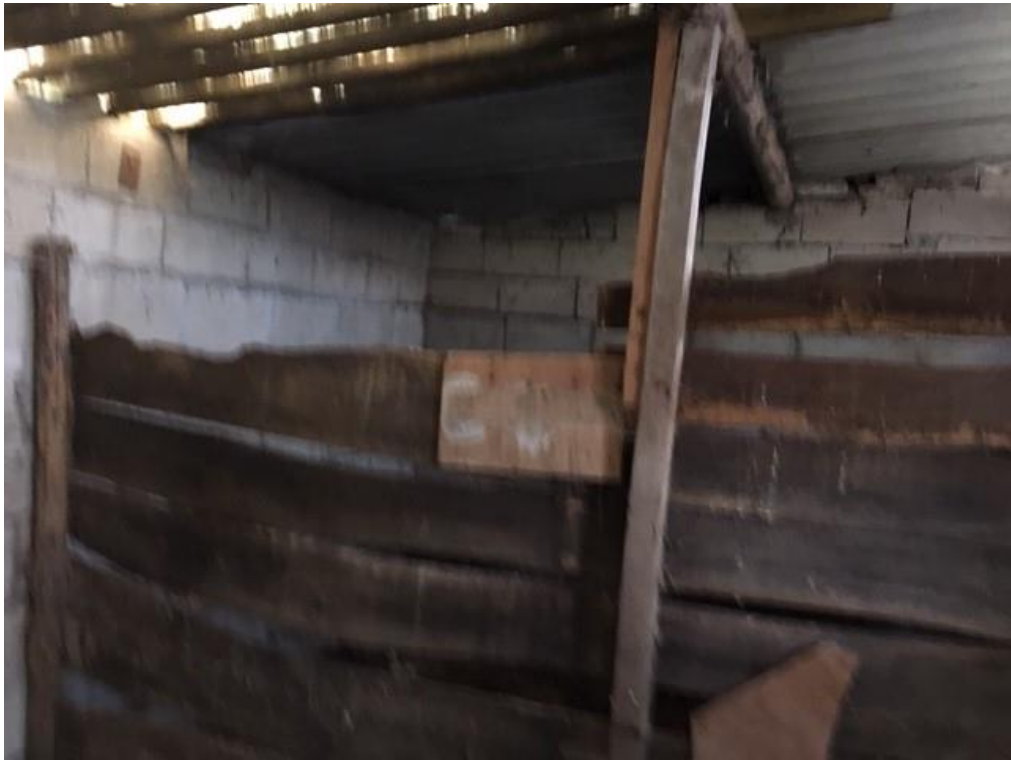
• Afbeelding 10: binnenzijde te slopen gebouw
