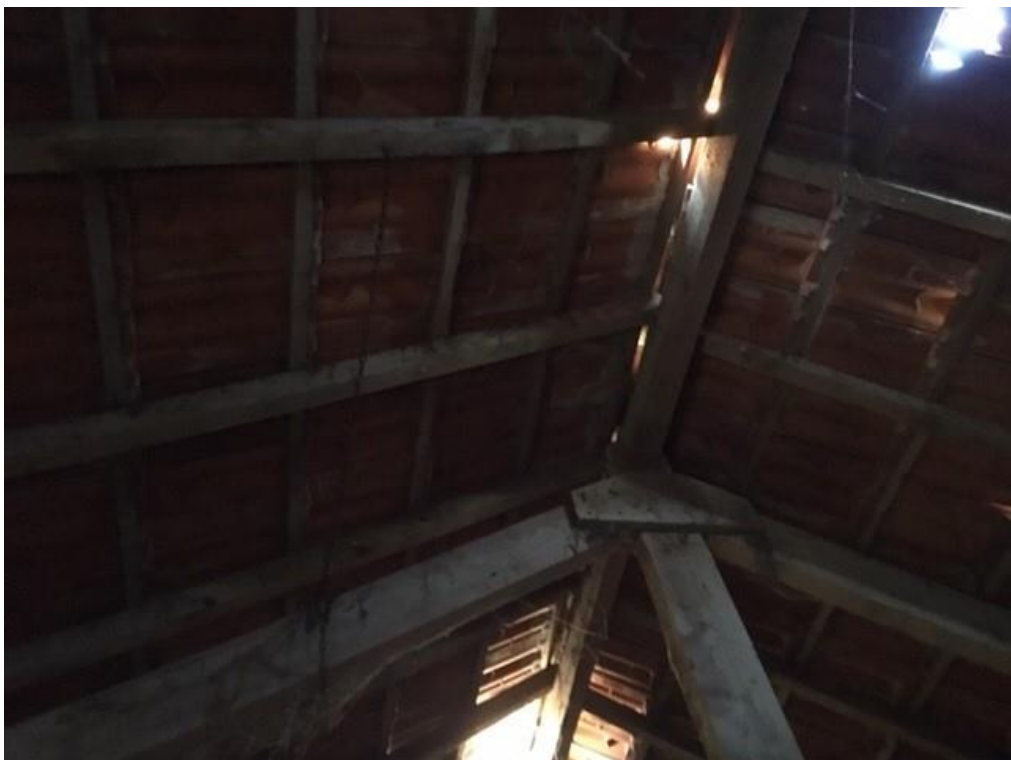
• Afbeelding 11: detail dakconstructie te slopen gebouw
