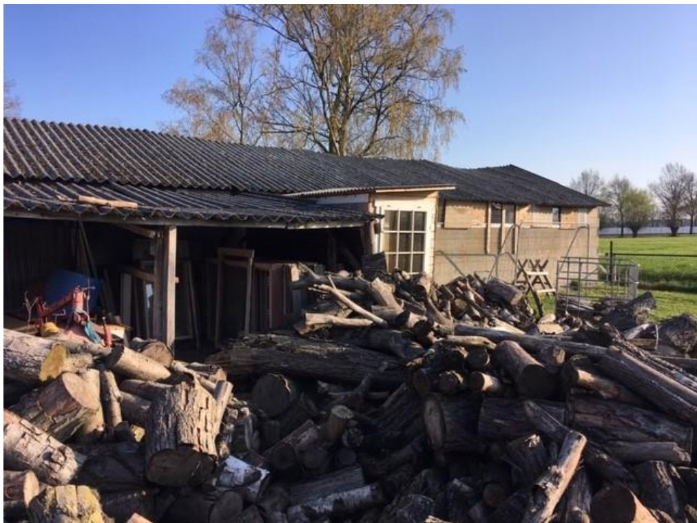
• Afbeelding 7: buitenzijde te slopen gebouwen
