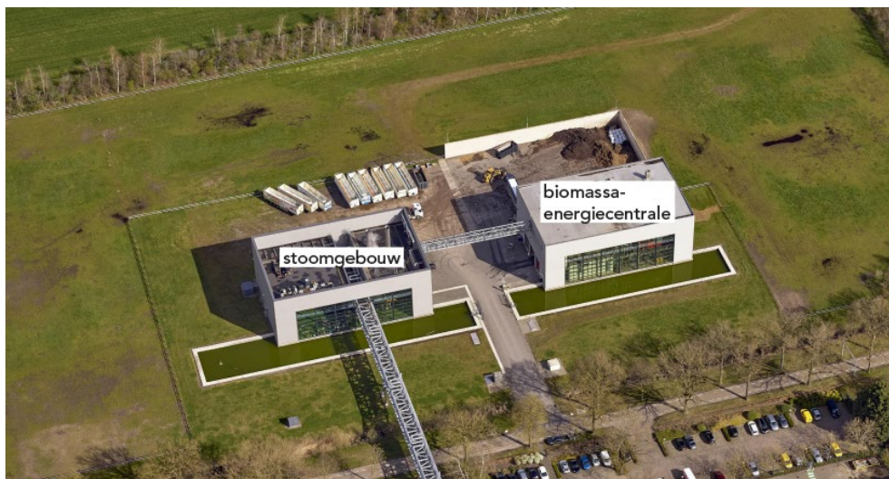
Figuur 19: foto stoomgebouw en biomassaenergiecentrale
