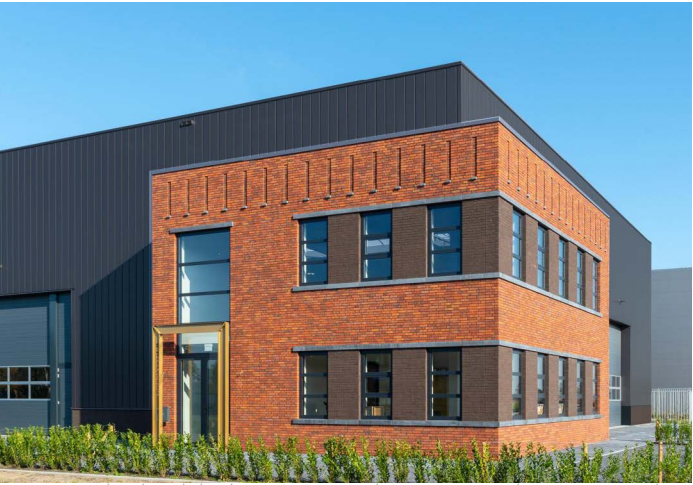
Materiaalgebruik baksteen in combinatie met plaatmateriaal
