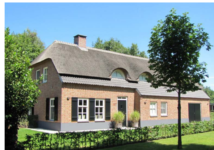
Woningbouw met landelijke uitstraling
