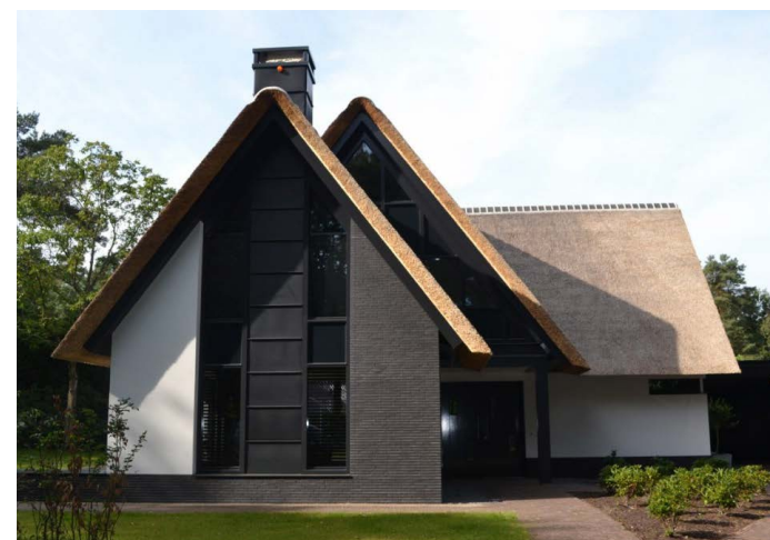
Samengesteld dak met rieten kap
