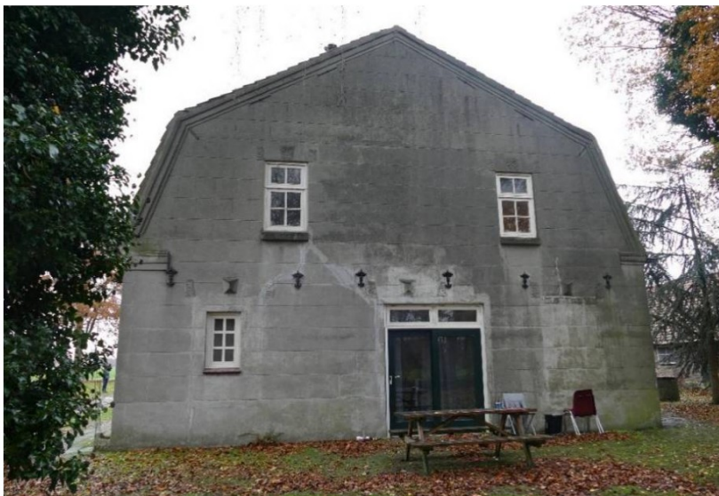
In blokverband besmeerde kopgevel
