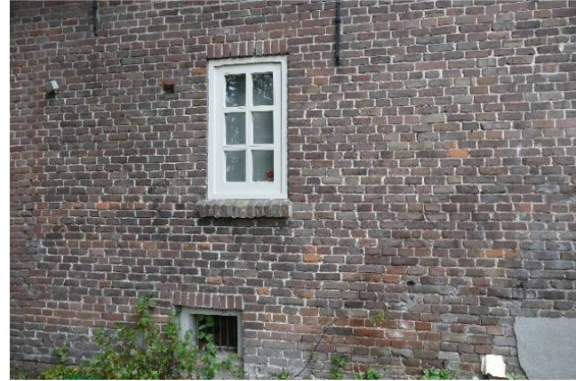
Opkamerraam en getralied raam van kelder.
