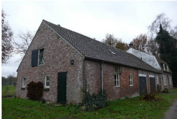
achterhuis met kopgevel
