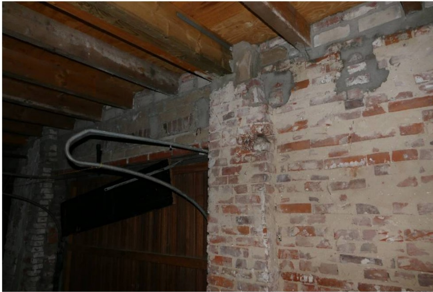
Binnenzijde van de gevel van het schuurgedeelte, met naast de deur een penant. Het deel van gevel is nog van de boerderij uit de negentiende eeuw.
