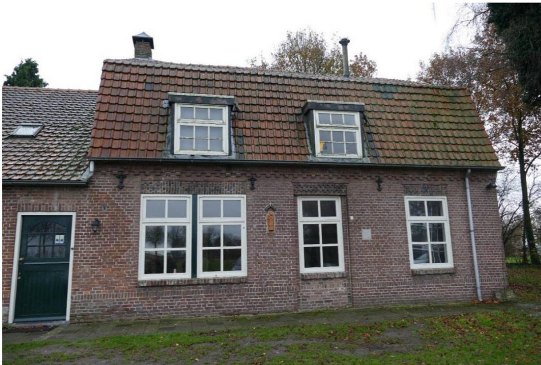
Het oorspronkelijke symmetrische woongedeelte van voordeur met aan elke zijde een venster is verdwenen. Het Mariabeeldje, de nis van de voordeur en de jaartalsteen liggen zonder de aanwezigheid van een voordeur wat verloren in de gevel.
