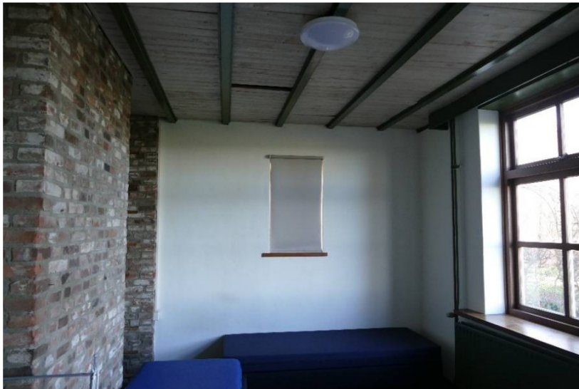
Balkenplafond van de opkamer is tussen de balen afgetimmerd met dunne plankjes. De balen zijn veel hoger en dateren waarschijnlijk nog uit de boerderij van het derde kwart van de negentiende eeuw.
