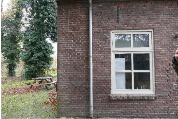
Later aangebracht venster in voorkamer
