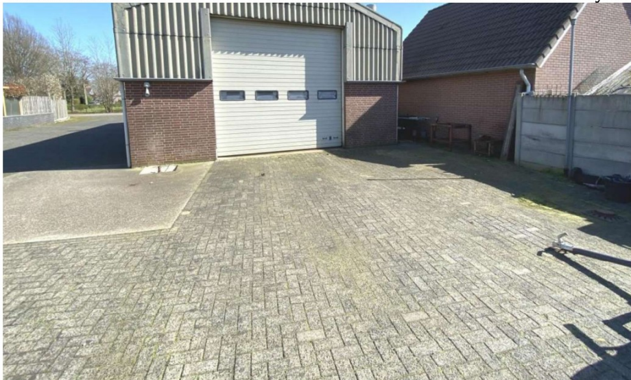
foto 5: tankplaats en ondergrondse dieseltank
