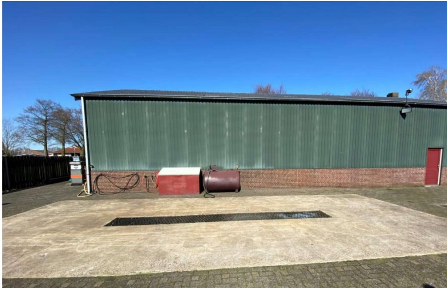
foto 4: wasplaats, bovengrondse dieseltank en OBAS
