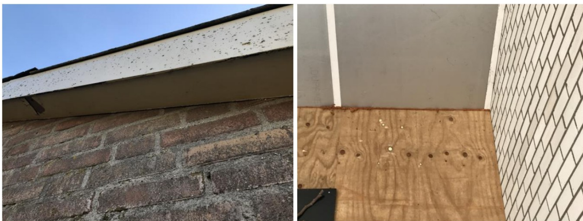
Afbeelding 9 en 10: Overstek goed aansluitend aan buitenmuur en kieren goed afgesloten met perschuim. Bron: [REDACTED]
