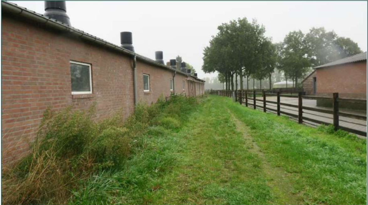
Figuur 1.2 De bebouwing in het plangebied betreft een woning en meerdere varkensstallen.
