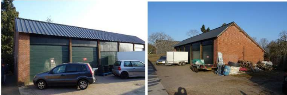
Afbeelding 3 en 4: deels te slopen bebouwing. Bron: BNL advies. Datum: 28-03-2022
