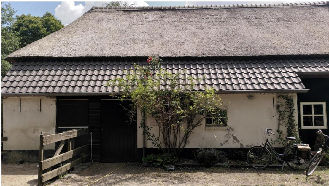
15. Gevel van het schuurgedeelte.
