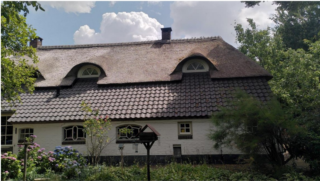
13. Lage gevel woon- en stalgedeelte.
