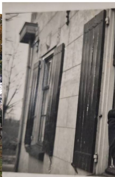
De eertijds uit de gevel stekende bakgoot boven de console.
