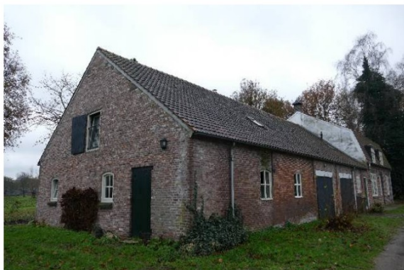
achterhuis met kopgevel
