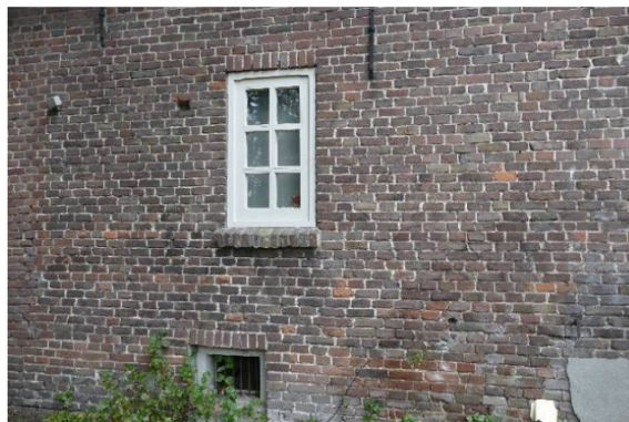
Opkamerraam en getralied raam van kelder.
