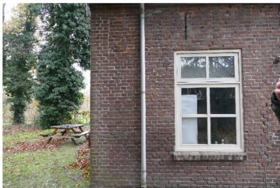
Later aangebracht venster in voorkamer
