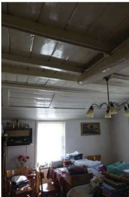
Houten betimmering en uiteinde van moerbalk.
