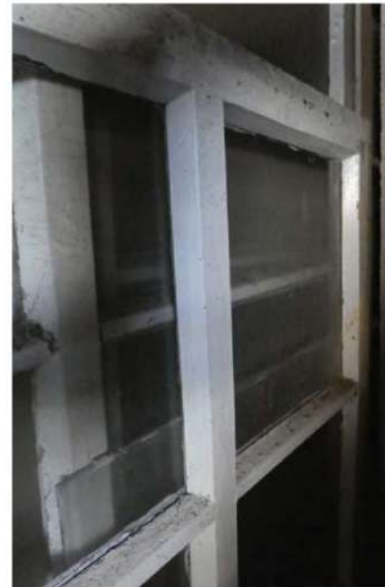
Detail van originele ramen.
