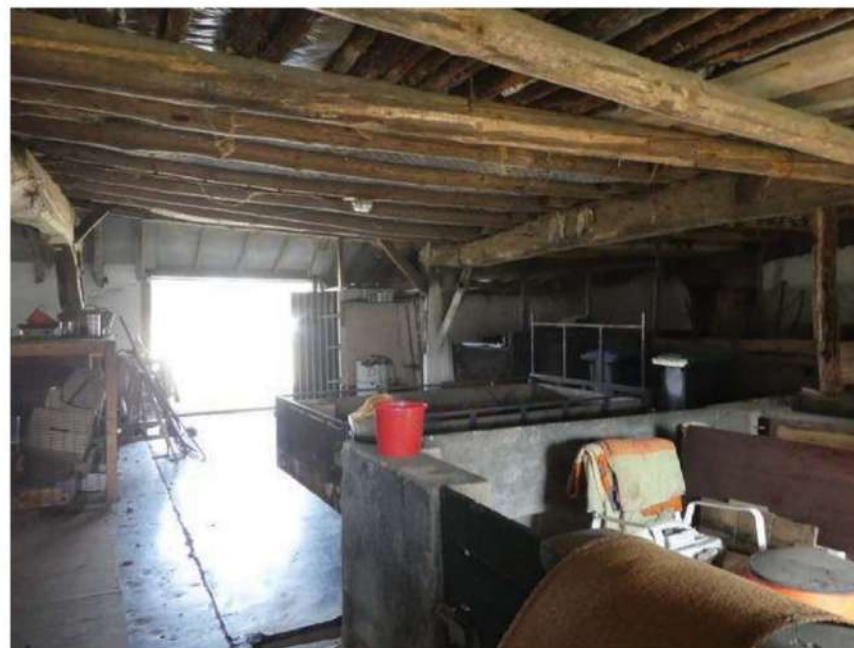
Overzicht op stalruimte, gezien richting de straatgevel.
