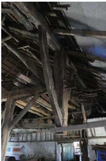
Afgezaagde gebintstijl B7 met oorspronkelijke 'staande' schoren.
