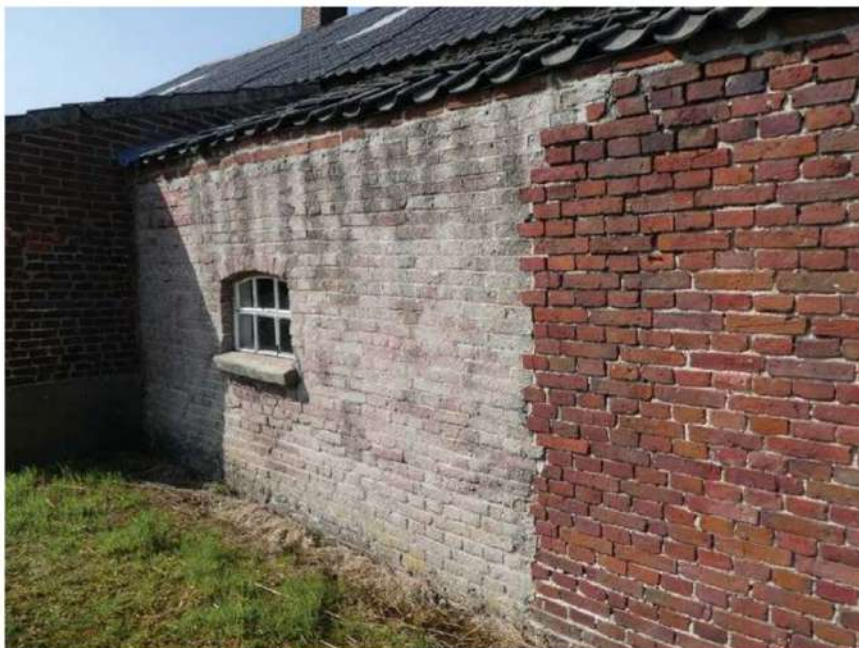
Dichtgezetste postaldehyd met (oorspronkelijk gerode) cementsteen.
