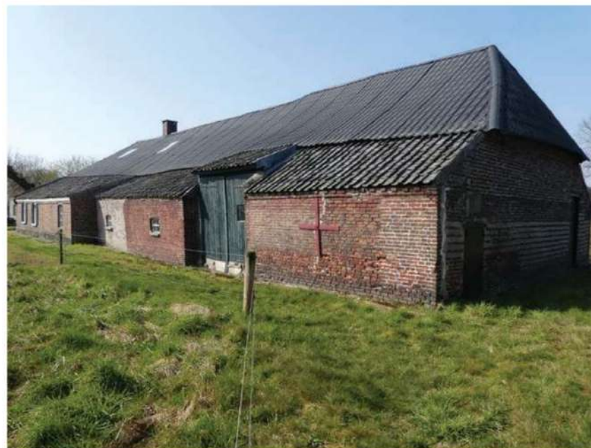
Rechterzijde van zuid-oostgevel.
