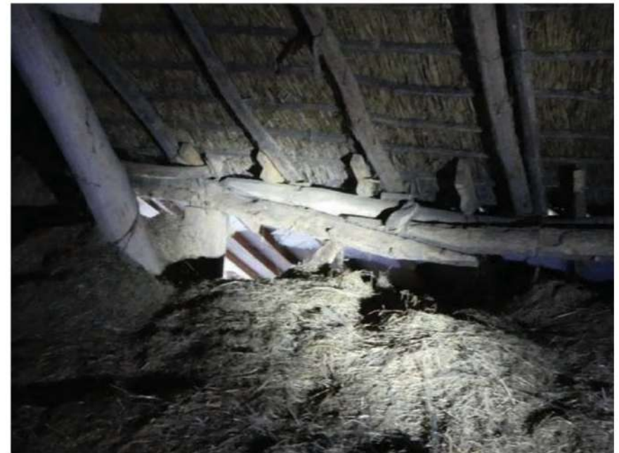
Samenkomst van oude eiken gebintplaten (str. B) boven gebintvak 5-6 en bijgeplaatste plaat..
