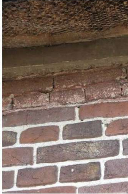
Herstellingen onder de muurplaat met gerede cementsteen.
