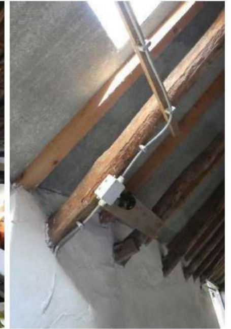
Dubbele dakconstructie (oud en nieuw) in stal.
