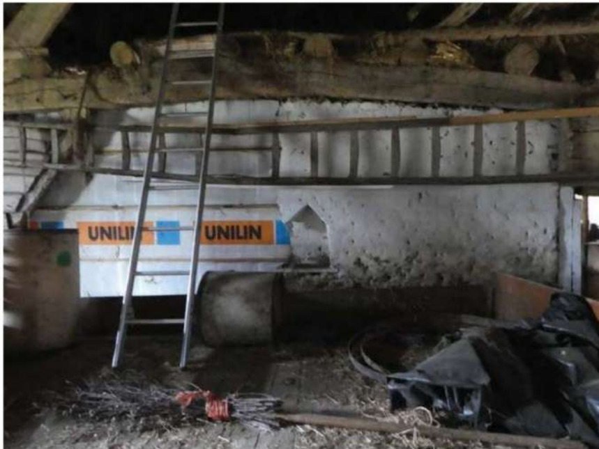
Scheidingsmuur tussen stal en schuur met centraal een kaarsnis (linker deel is weggefallen).
