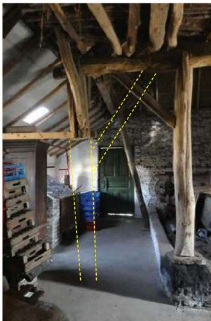
Afgezaagde gebintstijl B7, op de achtergrond schuingeplaatste stijl B6. In geel de reconstructie van stijl en korbeel.
