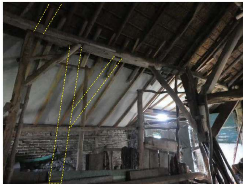
Cebintplaat en stijl op C8. In geel de oude locaties van stijl, schoor en eindplaat.
