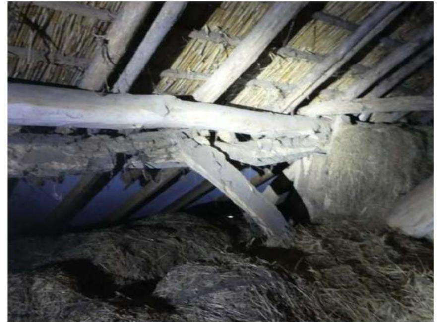
Samenkomst van oude eiken gebintplaten (str. C) boven gebintvak 5-6 en bijgeplaatste plaat..
