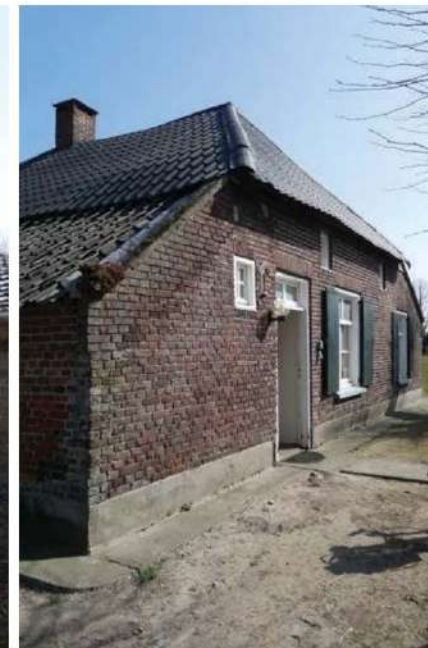
Voor- of zuidwestgevel.
