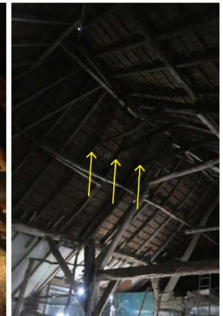
Dakconstructie boven schuur met enkele oude beroette eiken daksporenparen met hanenbalk.
