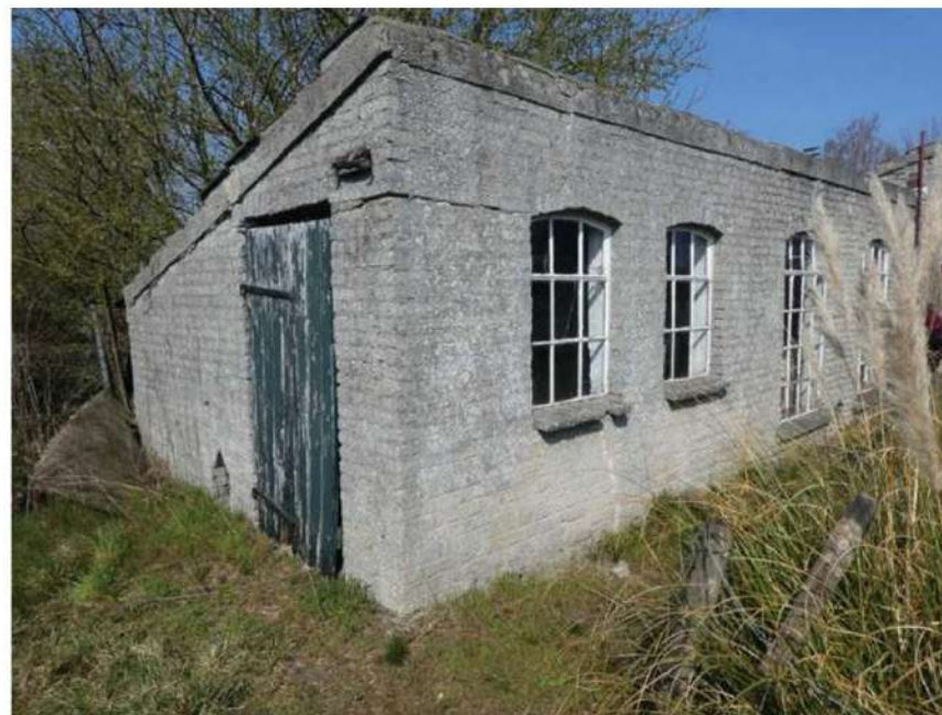
Opfok-kooi, exterieur, in het midden is een bouwnaad te zien.
