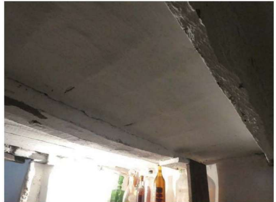
Detail van spelderwerk tussen vloerbalken.
