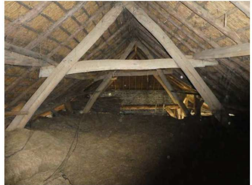
Dakconstructie boven stal.
