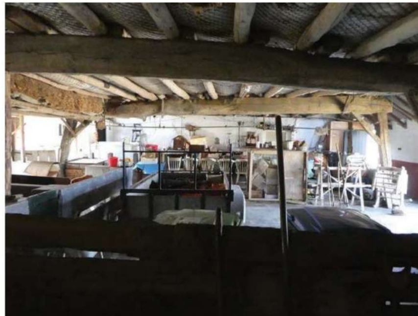
Overzicht op stalruimte, gezien richting de voorstal.
