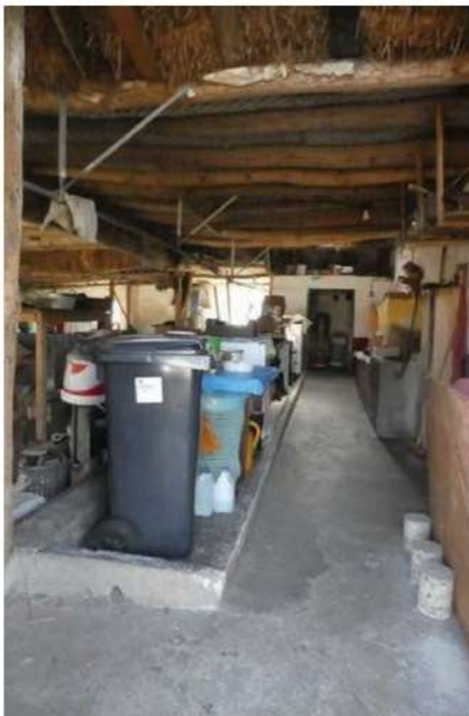
Voergoot van koestand aan voorstal. Op de achtergrond de knechtenkamer.
