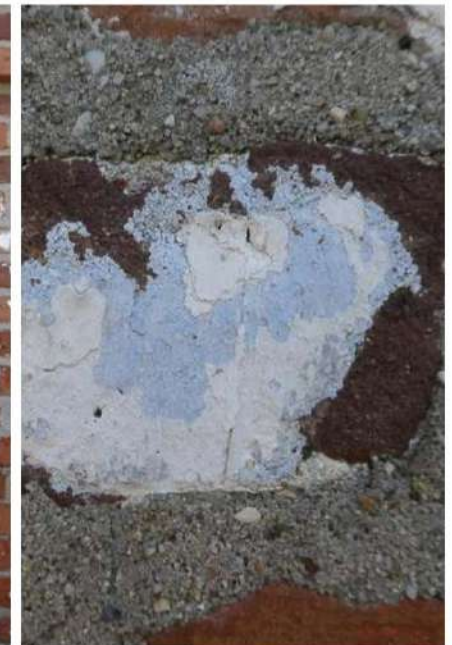
Detail van gekalkt afweerkruis boven kelderlicht.
