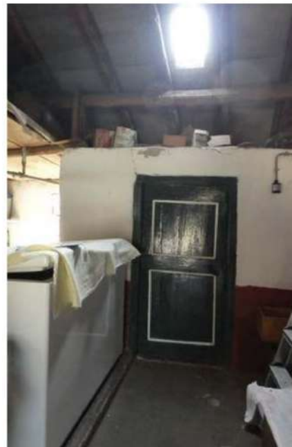
Opgeklampte toegangsdeur van knechtenkamer.
