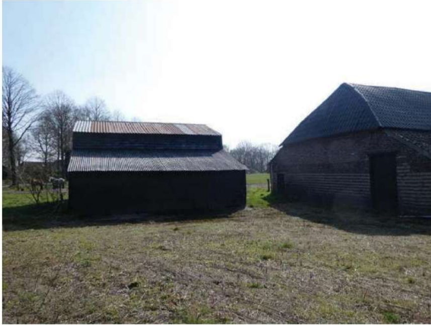
Veldschuur, exterieur noord-westzijde.
