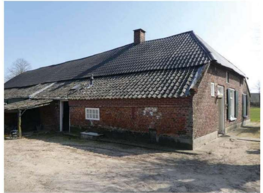
Rechterdeel van straatgevel.
