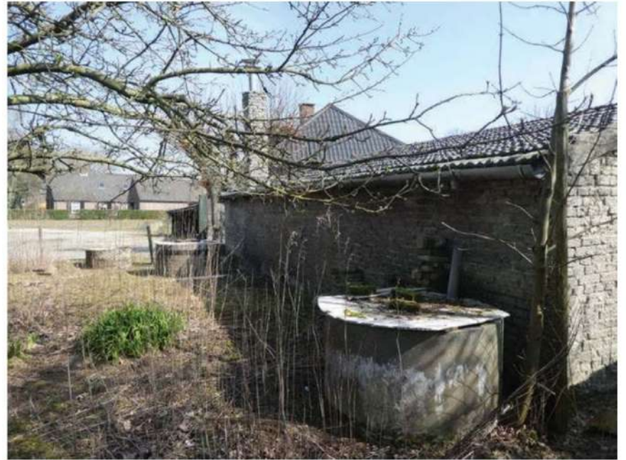
Waterput en regenwaterput tegen kippenhok.
