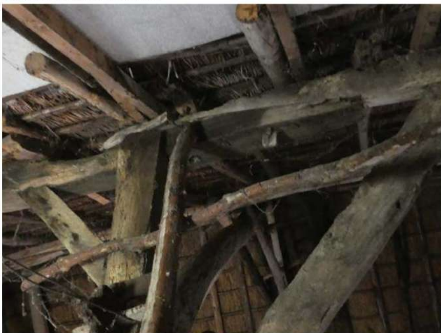
Fraaie las met toognagels en wig nabij gebinstijl C7. De linker schoor is t.b.v. de doornit in tweede instantie hoger aangebracht.
