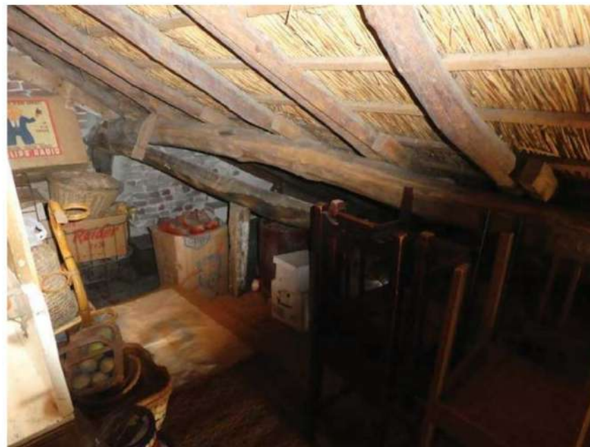
Cebintplaat / gording op str. C, boven het woonhuis.
