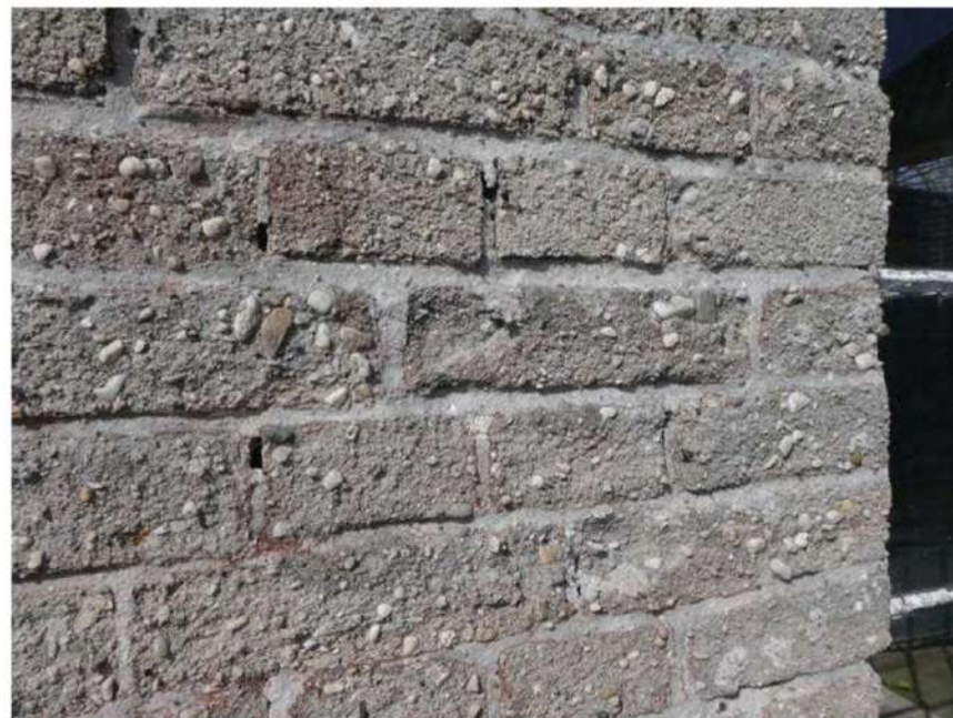
Kippenhok, detail van oorspr. geroerd metselwerk van grove cementsteen.
