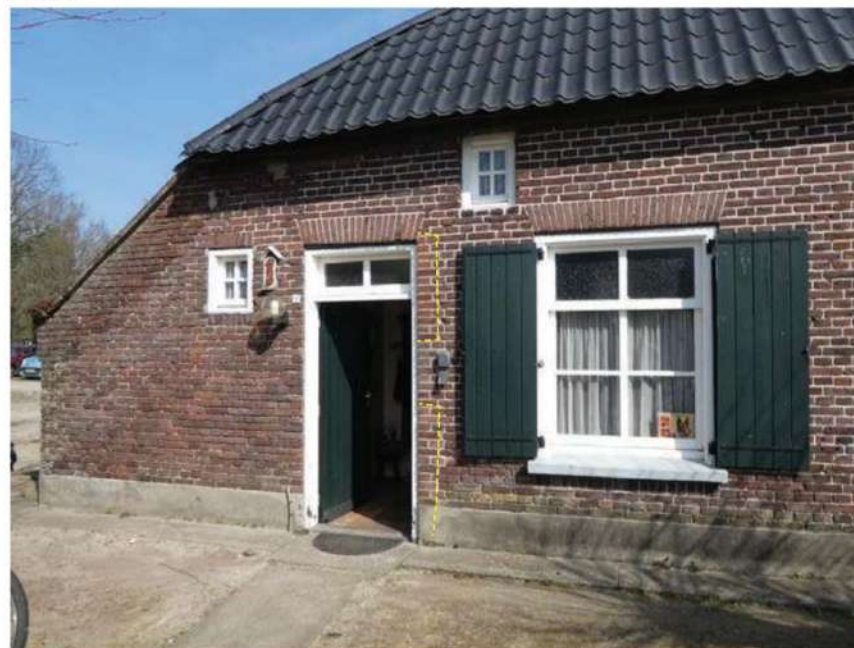
Detail van voor- of zuidwestgevel.
