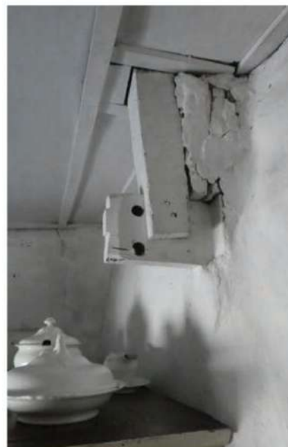
Ondersteuning van gebintplaat (str. B) op uiteinde van haardbalk (pen met bouwsporen van verbinding met stijl.)
