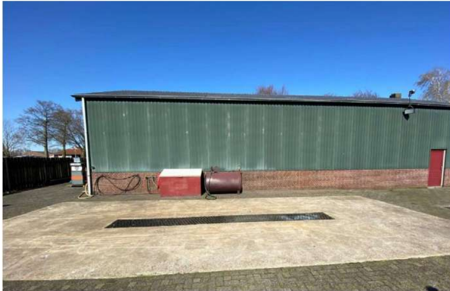
foto 4: wasplaats, bovengrondse dieseltank en OBAS
