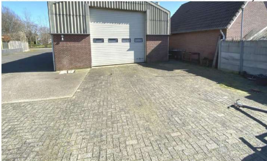
foto 5: tankplaats en ondergrondse dieseltank
