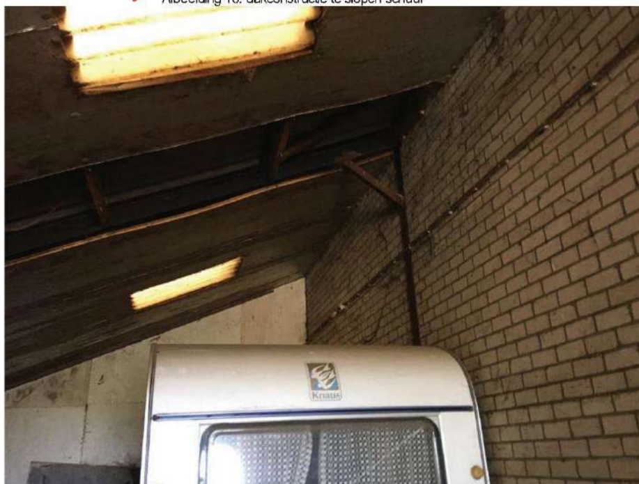
• Afbeelding 18: dakconstructie te slopen schuur
