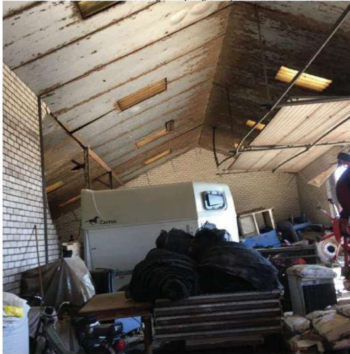
• Afbeelding 31: opslag te slopen schuur
