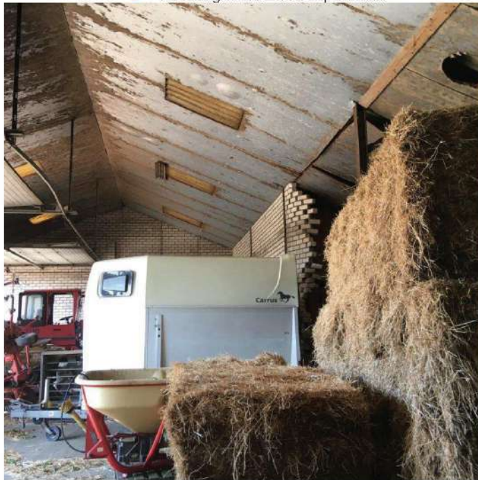
• Afbeelding 30: aanzicht te slopen schuur
