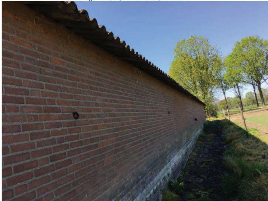
• Afbeelding 14: buitenzijde en dak te slopen schuur
