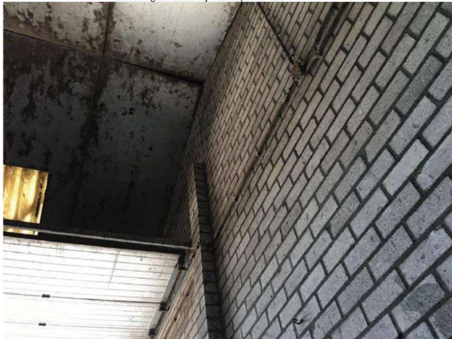
• Afbeelding 12: binnenzijde te slopen schuur
