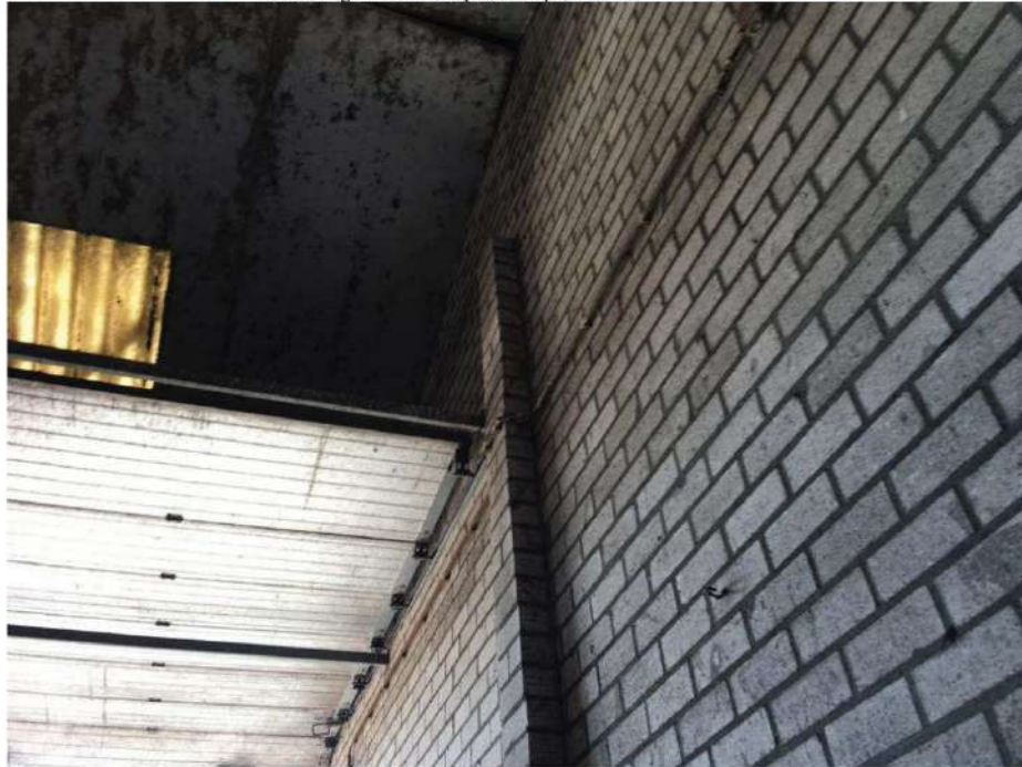
• Afbeelding 11: binnenzijde te slopen schuur
