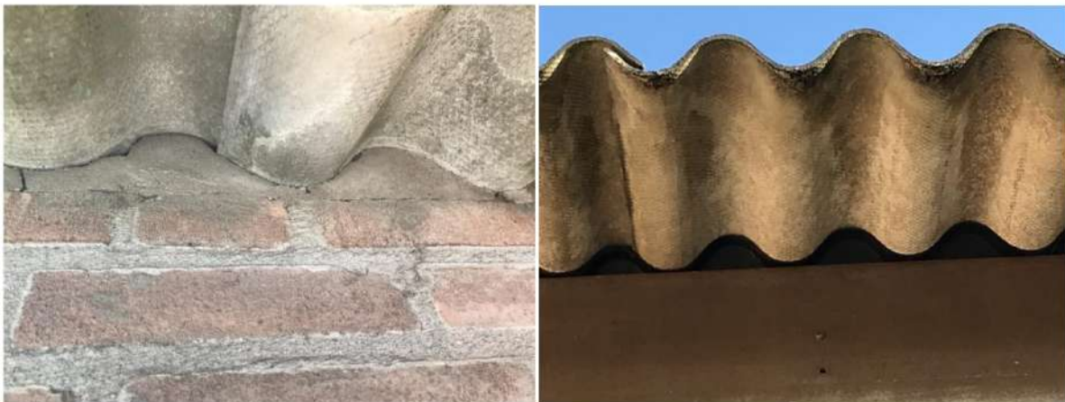
Afbeelding 6 en 7: Daken met vogelschroot en cement om de toegang te versperren. De aanwezigheid van huismussen is uitgesloten door het ontbreken van mogelijk geschikte verblijfplaatsen. Bron: [REDACTED] Datum: 12-04-2021
