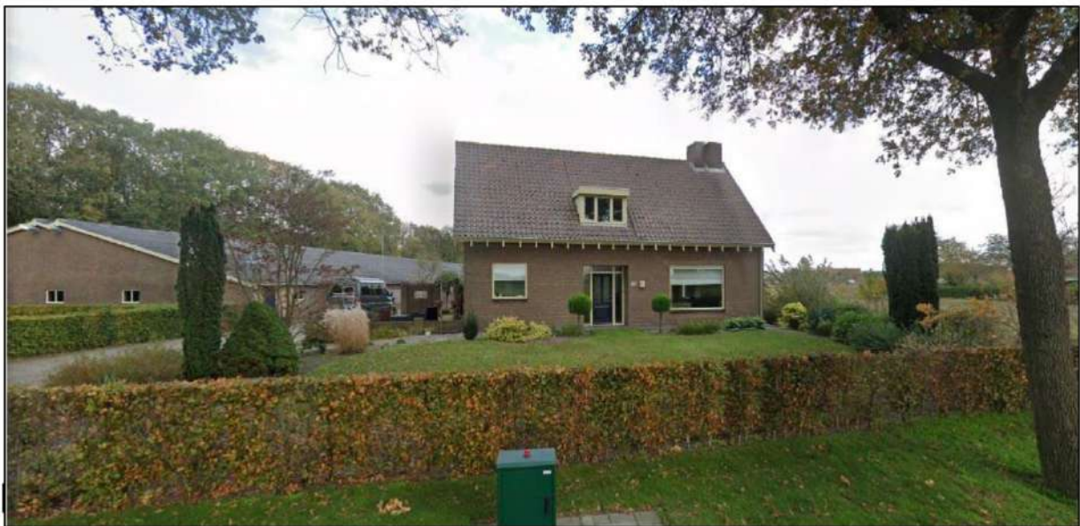
Figuur 4: Foto aanzicht locatie Strikseweg 3
