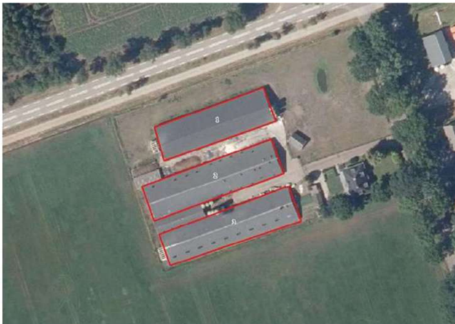
Figuur 12. Locatie 7, Rogstraat 1, Odiliapeel. De nummering van de gebouwen komt overeen met Tabel 7.
