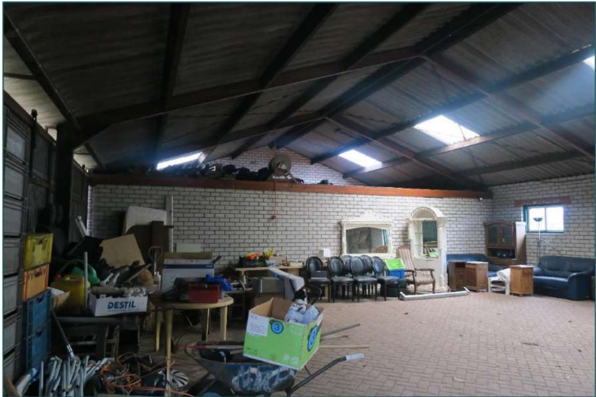
Figuur 3 De binnenzijde van de te slopen schuur.
