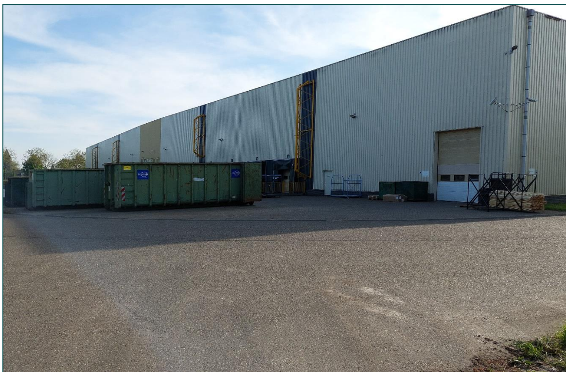
Figuur 2 De loods bestaat uit baksteenmuren en metalen damwandplaten.
