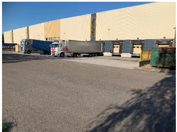
Figuur 2: laaddock ten oosten van de bestaande bedrijfsbebouwing, in zuidwestelijke kijkrichting. (Bron: MILON bv)
