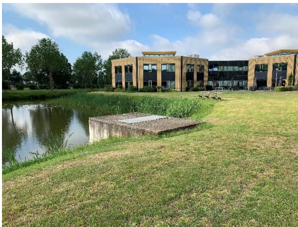
Figuur 1: kantoorpand aan de zuidelijke zijde van de onderzoekslocatie, in noordwestelijke kijkrichting. (Bron: MILON bv)
