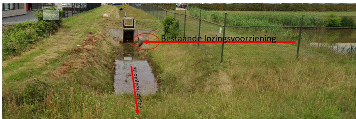
Figuur 11: Leegloopvoorziening bestaande buffer Linie 27 te Uden en blik op legger waterloop
