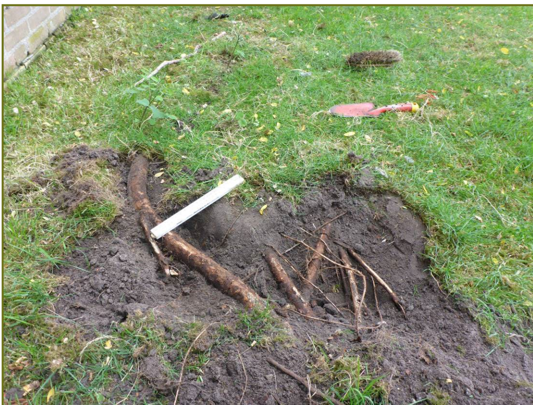
Afbeelding 25. Profielkuil 3 ondoordringbaar pakket wortels
