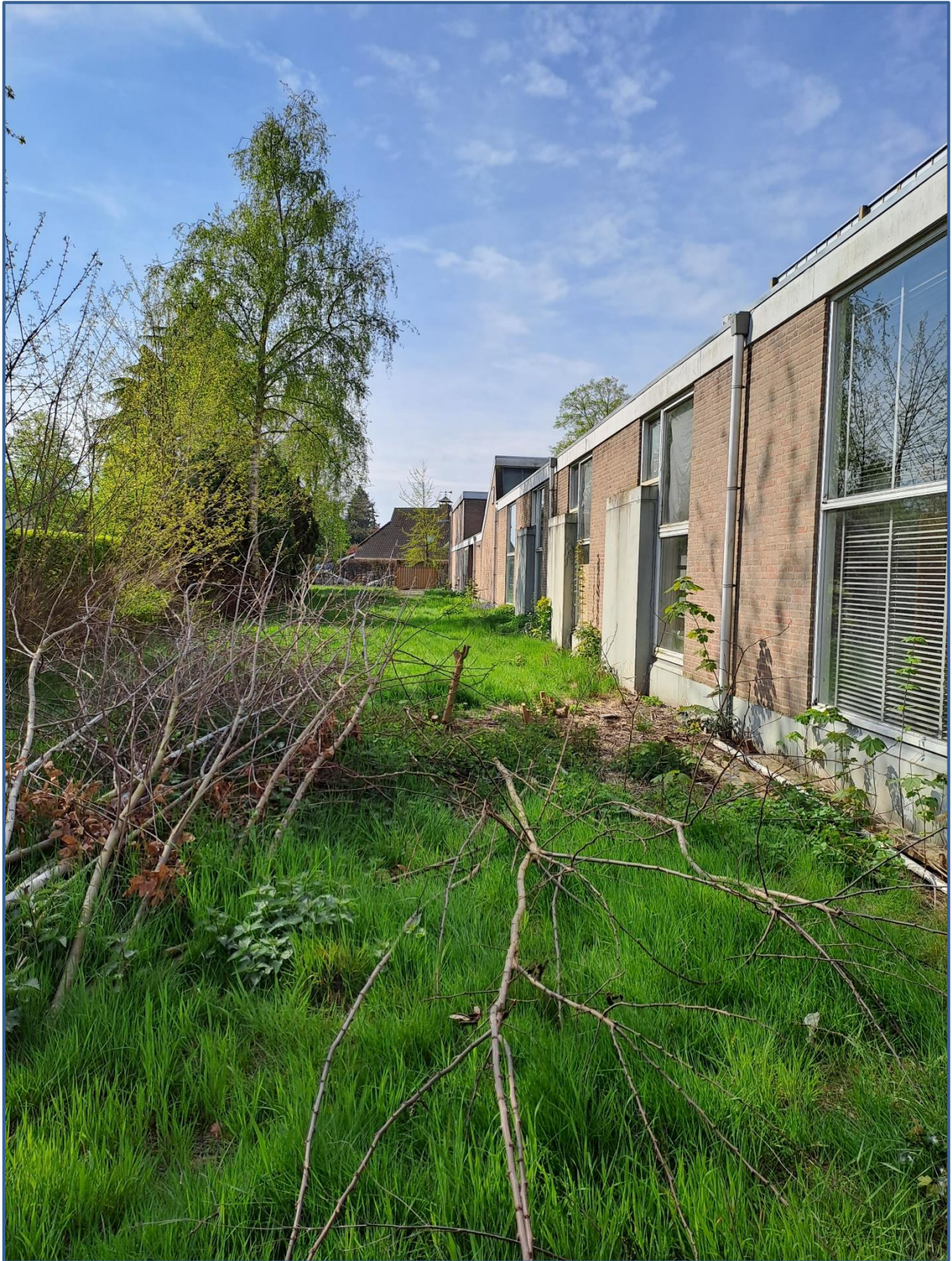
Oostgevel van de oude woningen.
