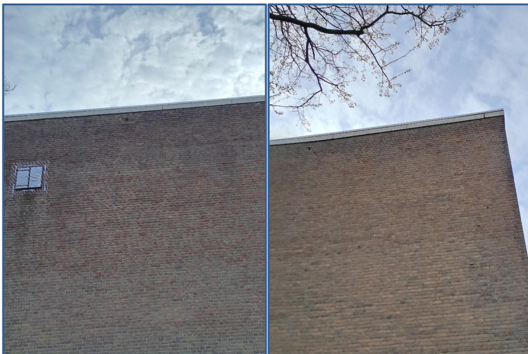
Stootvoegen onder de dakrand van de westgevel.
