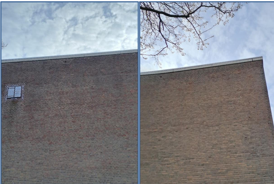
Stootvoegen onder de dakrand van de westgevel.
