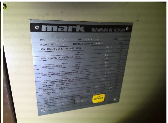
Foto 104 | Foto voor bron Luchtverwarmer MARK G 270 H, G 270 L 1979/01 1984/12
