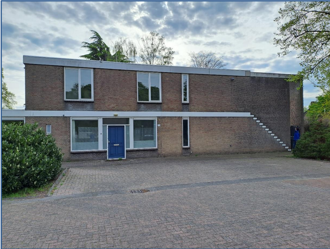
Westgevel van de oude woningen met boven de dakrand gevelbeplating waarachter vleermuizen kunnen schuilen.
