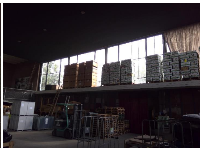
Piusplein 115: Foto 34 | Foto voor bron Beglazingskit
