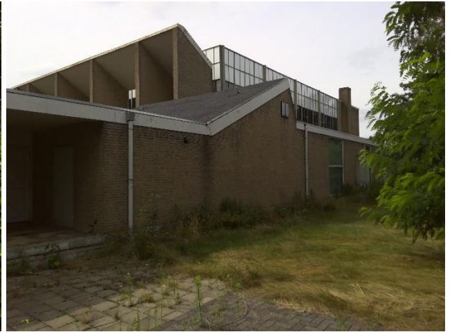
Piusplein 113: Foto 110 | Foto voor bron Buis / pijp
