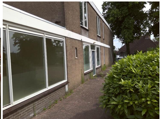
Piusplein 113: Foto 28 | Foto voor bron Beglazingskit
