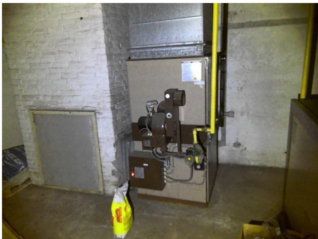
Foto 103 | Foto voor bron Luchtverwarmer MARK G 270 H, G 270 L 1979/01 1984/12
