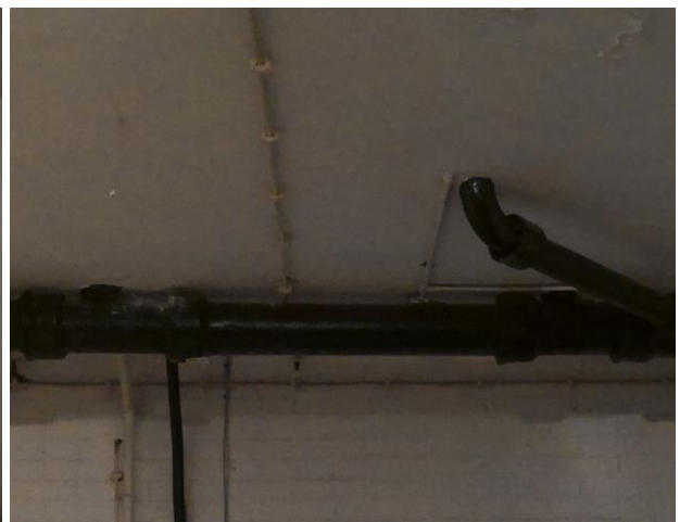
Piusplein 115: Foto 59 | Foto voor bron Buis / pijp
