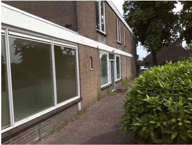
Piusplein 113: Foto 109 | Foto voor bron Buis / pijp
