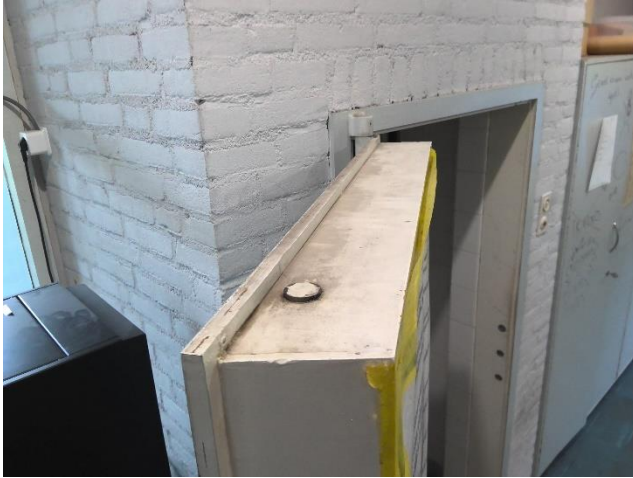
Piusplein 115: Foto 97 | Foto voor bron Isolatiemateriaal
