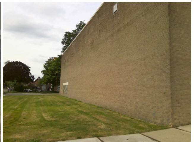
Piusplein 113: Foto 108 | Foto voor bron Buis / pijp
