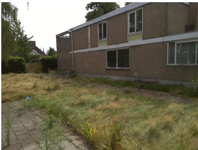
Piusplein 113: Foto 107 | Foto voor bron Buis / pijp
