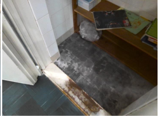
Piusplein 115: Foto 98 | Foto voor bron Isolatiemateriaal
