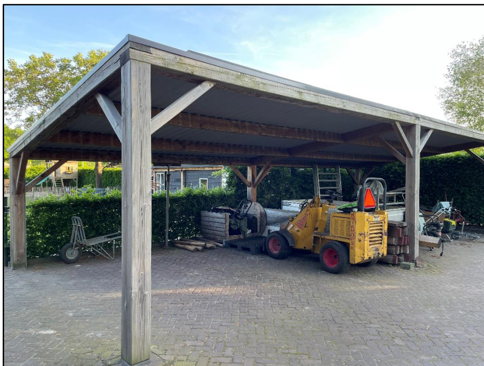
Afbeelding 13: weergave overkapping met daarop de zonne-energie installatie van 56 m 2
