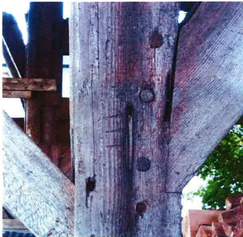
afbeelding 7. Gehakt telmerk op een van de gebintstijlen. Telmerken II, III en VI zijn groter ingekerfd.
