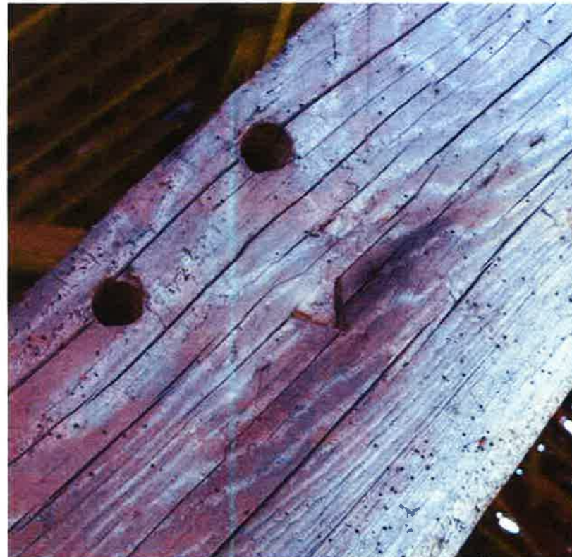
afbeelding 8. Telmerk V op een van de korbelen. Telmerken V en VII zijn kleiner ingekerfd.
