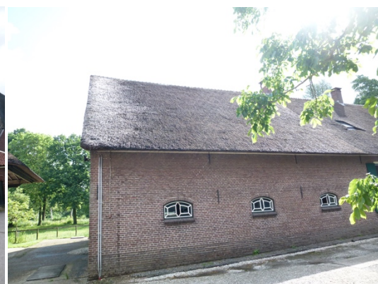
Locatie G, een deel van het woonhuis
