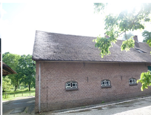
Locatie G, een deel van het woonhuis
