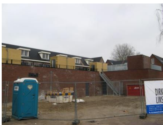
Foto 7: De bergingen op het dekniveau, gezien vanaf het van Rooyenplein
