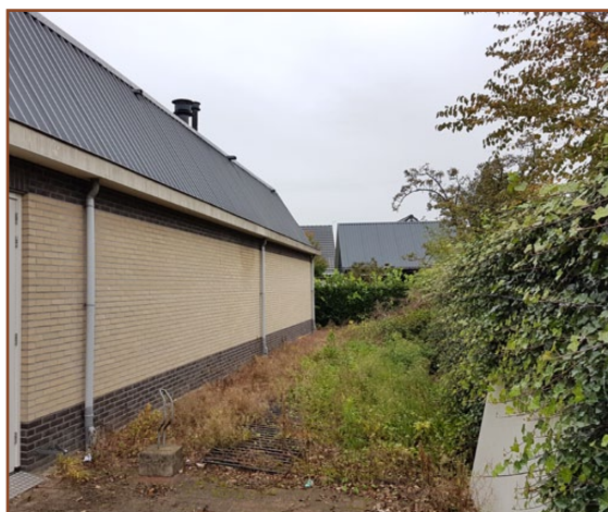
Afb. 2.7: Verruigde strook tussen oostgevel bakkerij en de achtertuin van Groote Woldweg 5. De begroeide erfafscheiding (rechts) heeft vermoedelijk een belangrijke functie voor huismussen.
