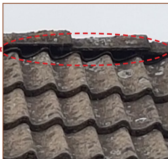
Afb. 2.10: Alle potentiële openingen in de pannendaken die vleermuizen en vogels toegang zouden geven tot de achterliggende ruimte zijn afgesloten met vogelschroot of fijnmazig gaas.
