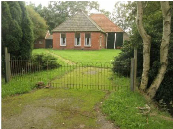
Foto1: Erf gefotografeerd vanaf de Abbendijk met van links naar rechts het bakhuisje, de woning en de vervallen schuur achter de woning
