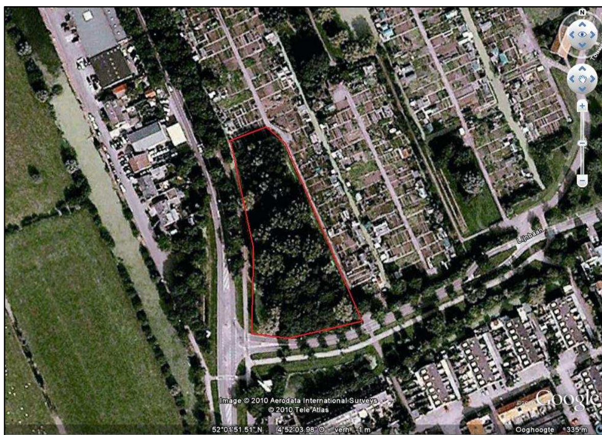
Figuur 1: Luchtfoto van het plangebied (rood omlijnd) (bron: Google Earth 2010).
