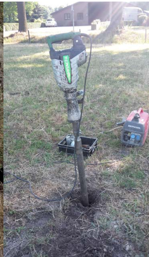
Foto 4. Plaatsing peilbuis met mechanische hulpmiddelen
