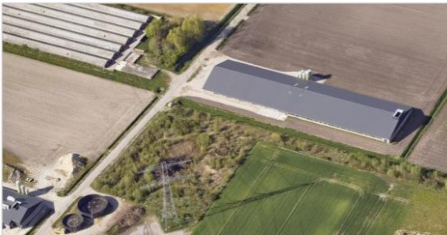
Figuur 4: Luchtfoto zeugenstal op De Horsten 17 in deelgebied 3 (Bron: App Slagboom en Peeters, obliekviewer, 18 april 2022)
