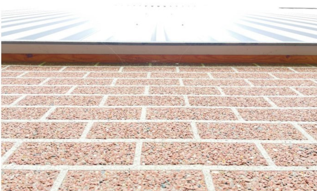
Foto 25: De afwerking van de stenenborstwering in de gevelplaten van de nieuwe stallen sluiten goed aan.
