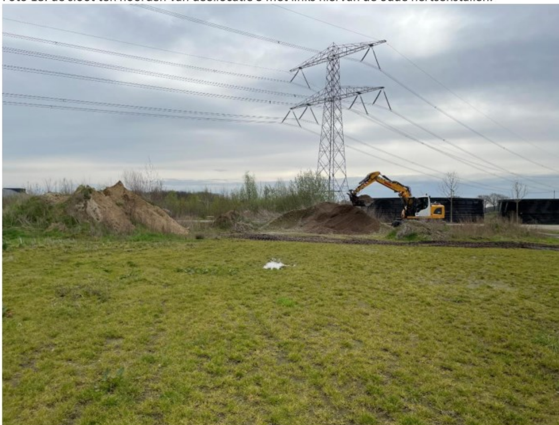
Foto 19: graafwerkzaamheden nabij deellocatie 3
