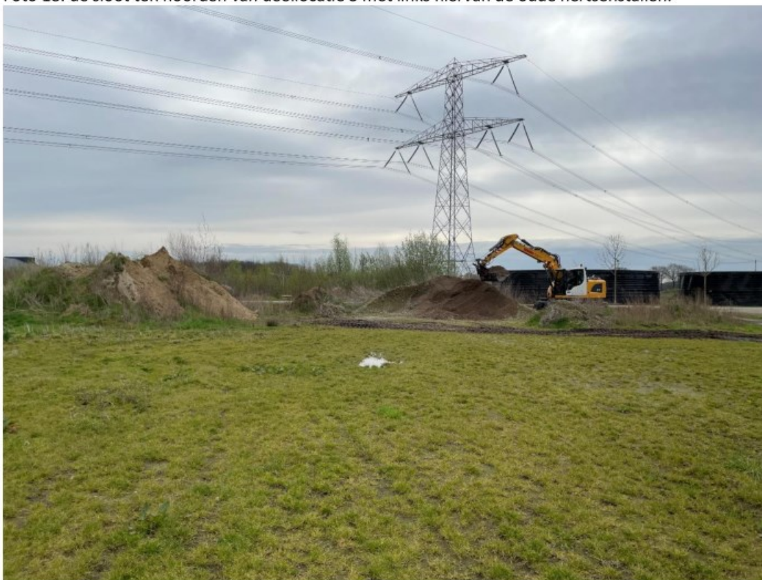
Foto 19: graafwerkzaamheden nabij deellocatie 3
