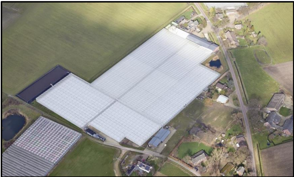
Afbeelding 4. Luchtfoto huidige situatie plangebied
