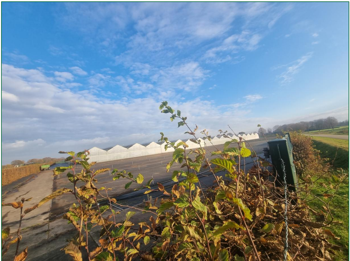
Afbeelding 19. Zicht op de bestaande foliekas en containervelden (leeg i.v.m. winterseizoen) vanaf Hazenakkerweg
